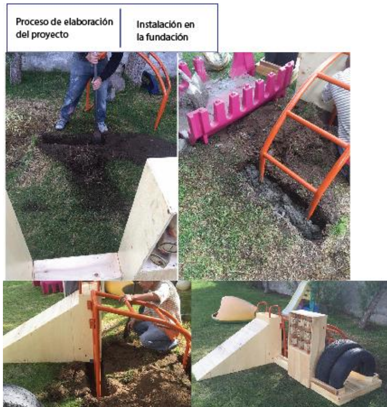
Imagen N.9: Instalación en la fundación.
