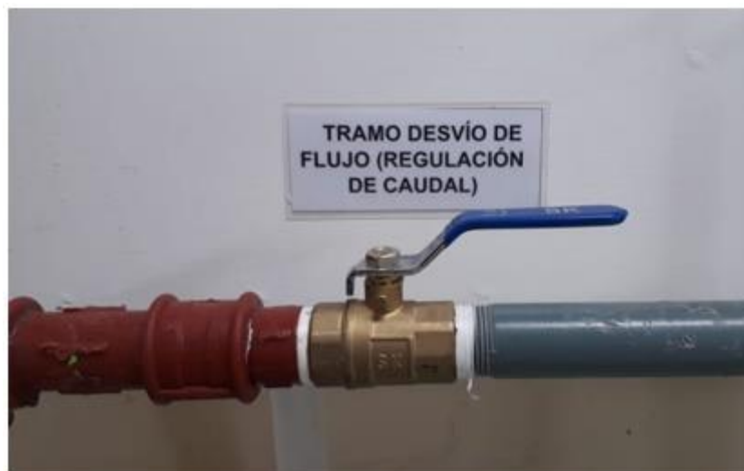
Fotografía 26. Válvula de bola (alivio). (Fuente: Fotografía de Paula Jaramillo y Jack Vásquez)
