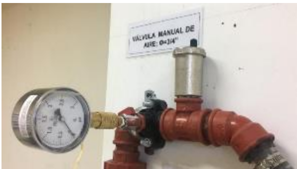
Fotografía 79. Medición con manómetro. (Fuente: Fotografía de Paula Jaramillo y Jack Vásquez)
