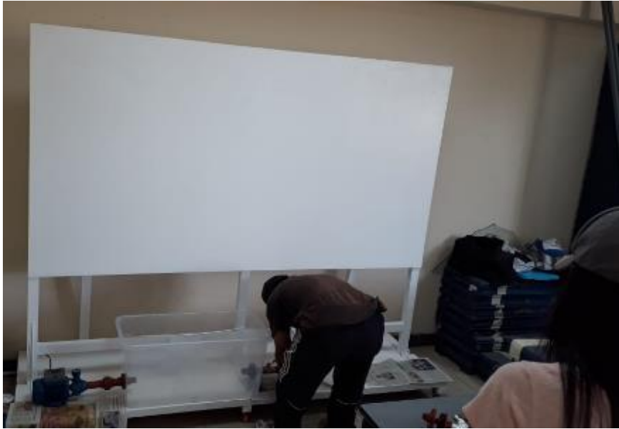
Fotografía 5. Unión tanques y bomba. (Fuente: Fotografía de Paula Jaramillo y Jack Vásquez)
