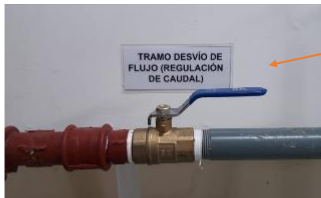
Fotografía 39. Válvula de regulación de caudal. (Fuente: Fotografía de Paula Jaramillo y Jack Vásquez)
