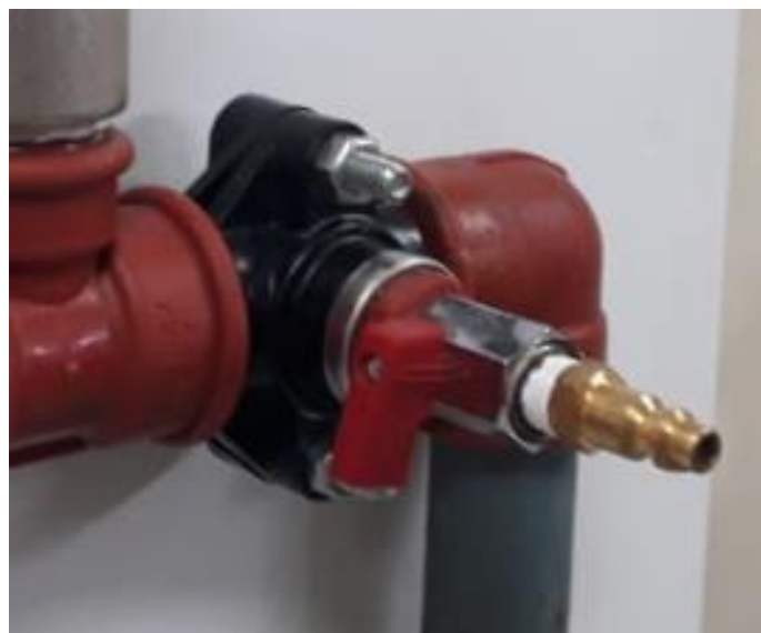
Fotografía 43. Válvula medición de presión cerrada. (Fuente: Fotografía de Paula Jaramillo y Jack Vásquez)
