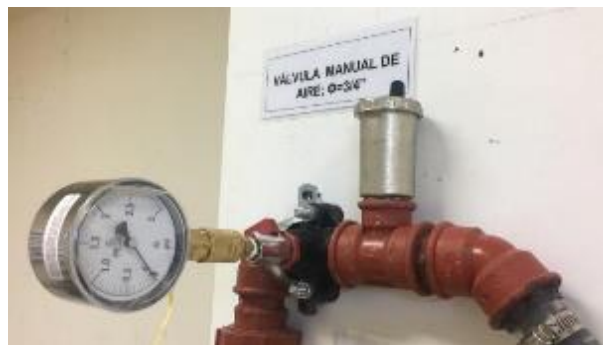
Fotografía 41. Conexión del manómetro. (Fuente: Fotografía de Paula Jaramillo y Jack Vásquez)
