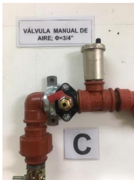
Fotografía 14. Válvulas de aire. (Fuente: Fotografía de Paula Jaramillo y Jack Vásquez)
