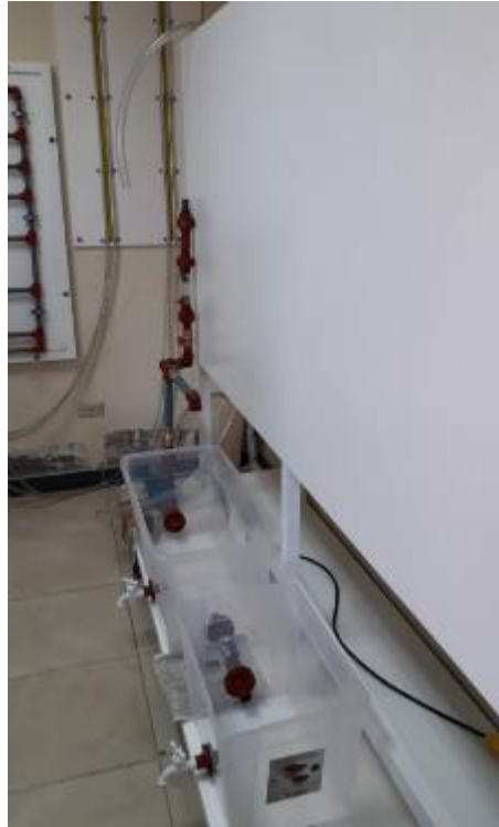
Fotografía 11. Tuberías y accesorios, se incluyen grifos en los tanques. (Fuente: Fotografía de Paula Jaramillo y Jack Vásquez)
