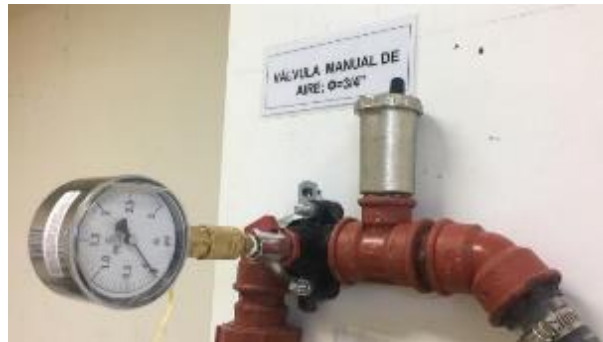
Fotografía 76. Conexión del manómetro. (Fuente: Fotografía de Paula Jaramillo y Jack Vásquez)
