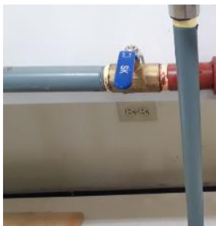
Fotografía 71. Válvula de salida. (Fuente: Fotografía de Paula Jaramillo y Jack Vásquez)
