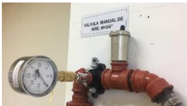
Fotografía 57. Conexión del manómetro. (Fuente: Fotografía de Paula Jaramillo y Jack Vásquez)
