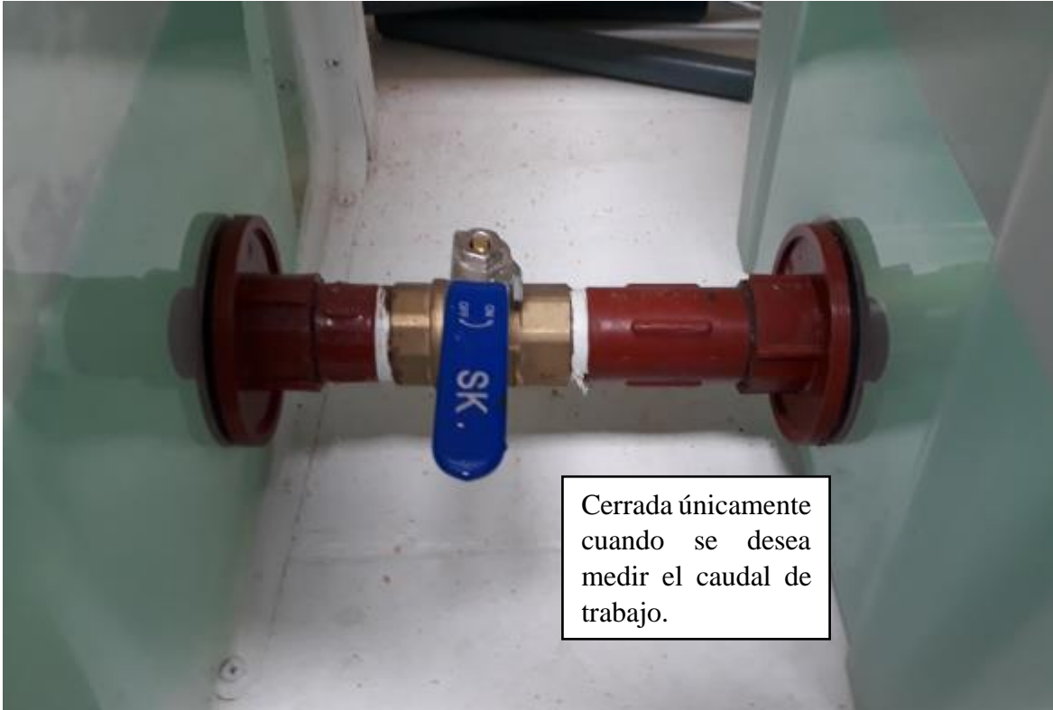
Fotografía 46. Válvula de interconexión de tanques cerrada. (Fuente: Fotografía de Paula Jaramillo y Jack Vásquez)
