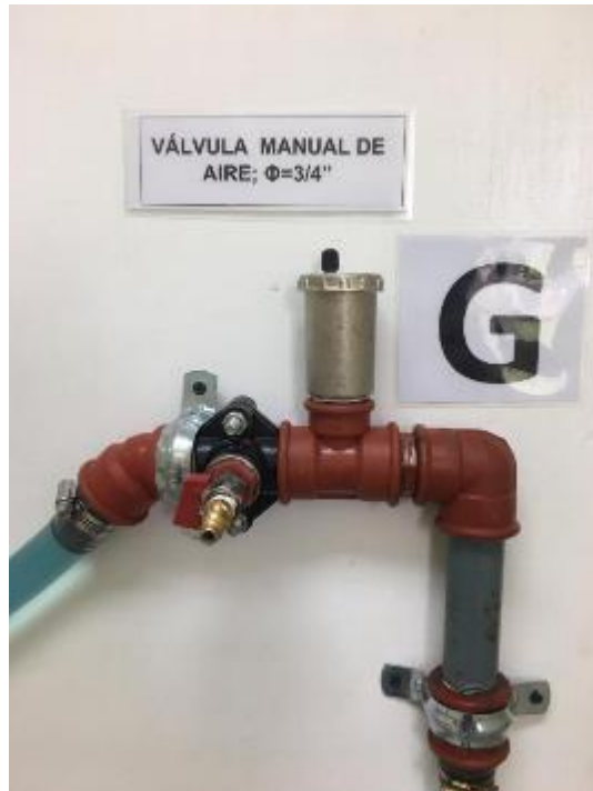
Fotografía 16. Válvulas de aire. (Fuente: Fotografía de Paula Jaramillo y Jack Vásquez)
