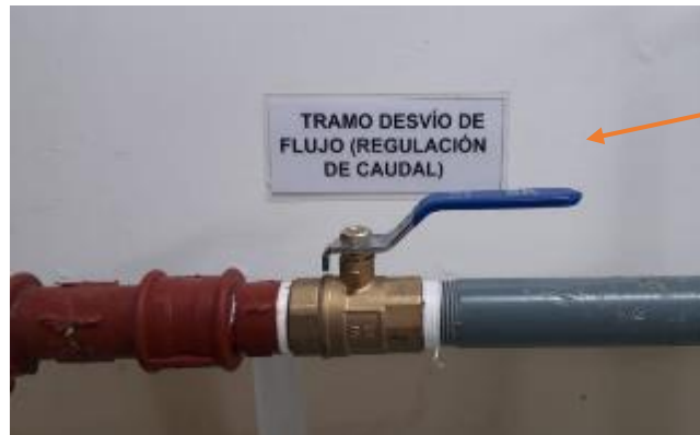
Fotografía 55. Válvula de regulación de caudal. (Fuente: Fotografía de Paula Jaramillo y Jack Vásquez)
