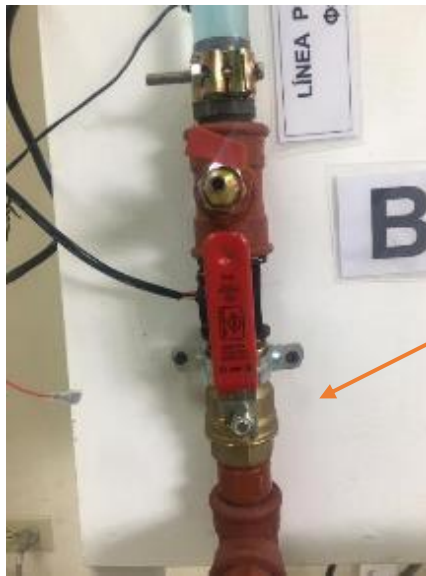
Fotografía 40. Válvula de paso línea principal. (Fuente: Fotografía de Paula Jaramillo y Jack Vásquez)
