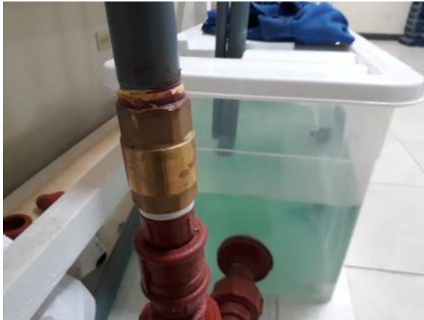
Fotografía 25. Válvula Check. (Fuente: Fotografía de Paula Jaramillo y Jack Vásquez)
