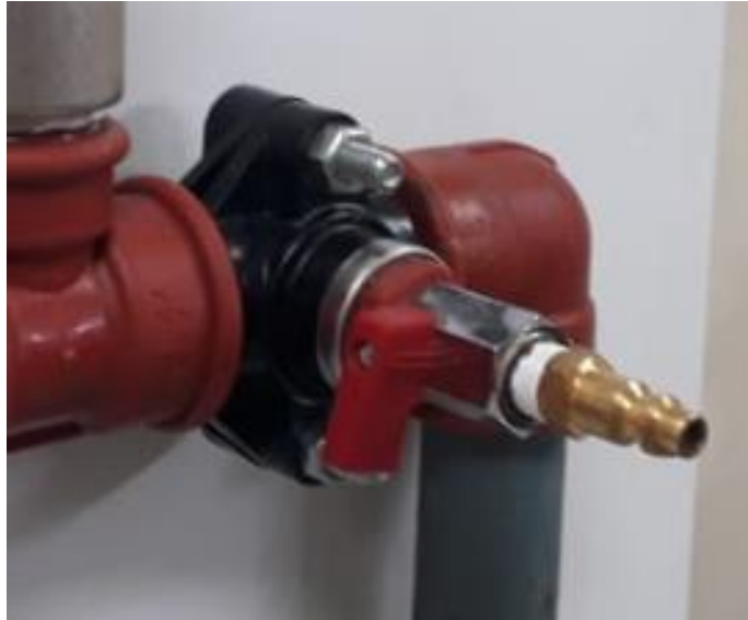
Fotografía 78. Válvula medición de presión cerrada. (Fuente: Fotografía de Paula Jaramillo y Jack Vásquez)
