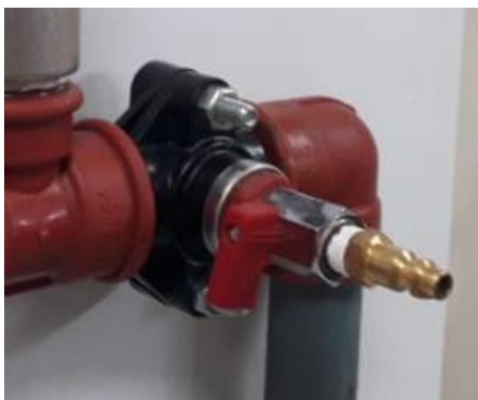
Fotografía 59. Válvula medición de presión cerrada. (Fuente: Fotografía de Paula Jaramillo y Jack Vásquez)
