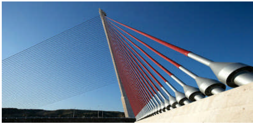
Figura 42: Cables Puente Atirantado de Talavera
