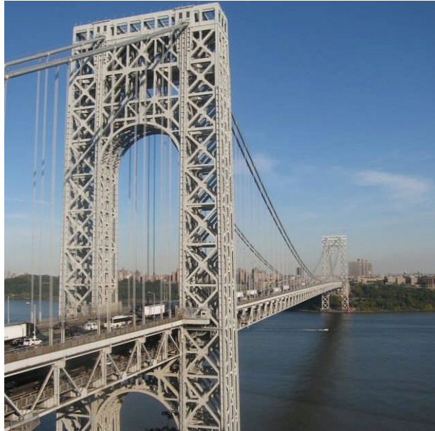
Figura 27: Puente Colgante George Washington
