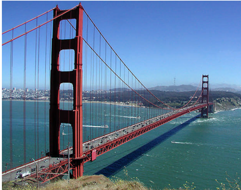
Figura 9: Puente Colgante Golden Gate FUENTE: (Wikipedia, 2007)
