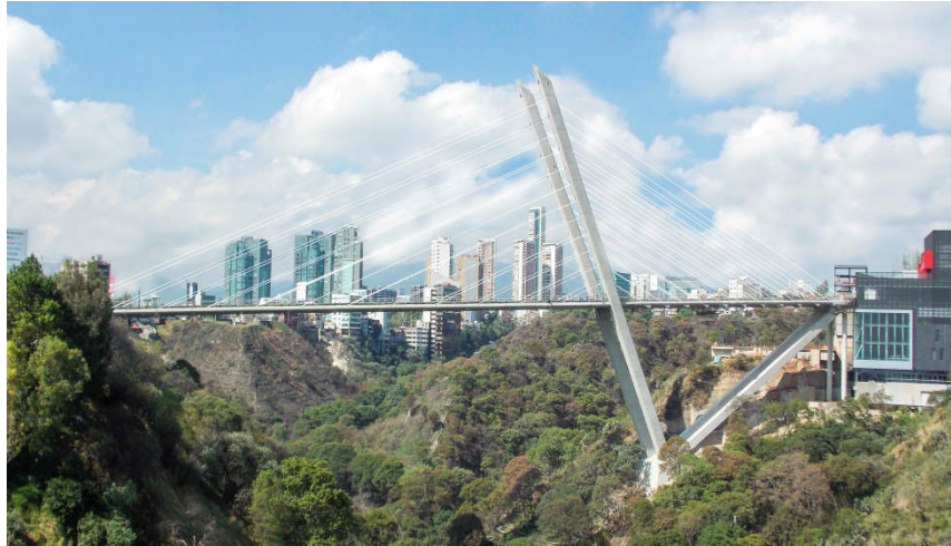
Figura 37: Torre inclinada Puente Atirantado de Vidalta (México) FUENTE: http://www.cfcsl.com/puente-vidalta-ciudad-de-mexico-mexico/
