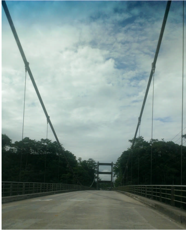
Figura 15: Puento Colgante Tena (entrada a la ciudad)
