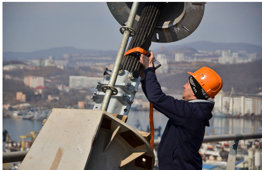
Figura 32: Conexión de torón a tablero FUENTE: http://goody-good.rssing.com/chan-2249406/all_p207.html
