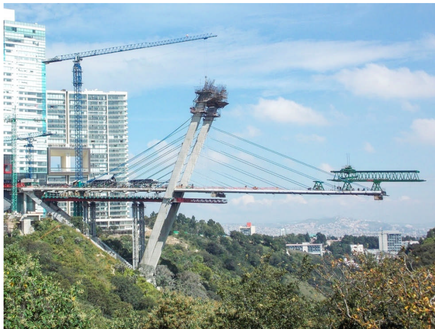
Figura 38: Torre inclinada Puente Atirantado de Vidalta (México) FUENTE: http://www.cfcsl.com/puente-vidalta-ciudad-de-mexico-mexico/
