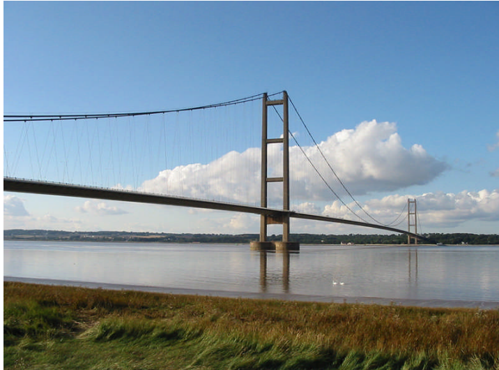
Figura 30: Puente Colgante Humber
