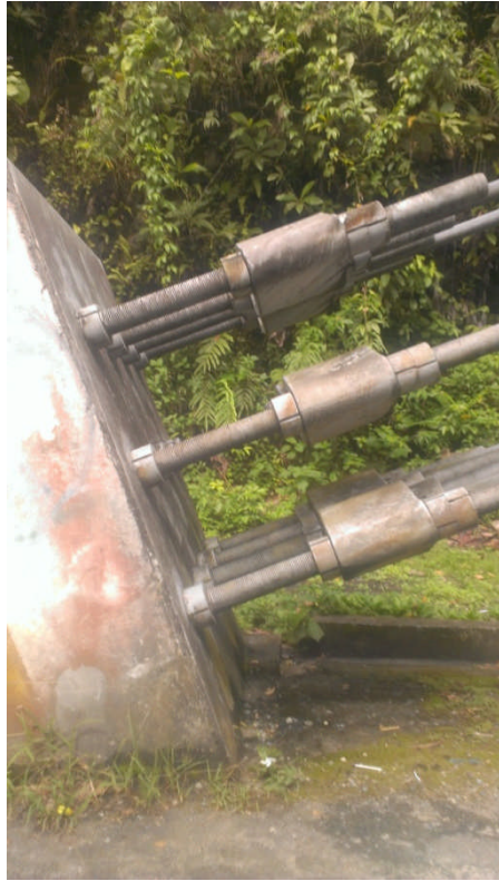
Figura 17: Anclado de cables principales
