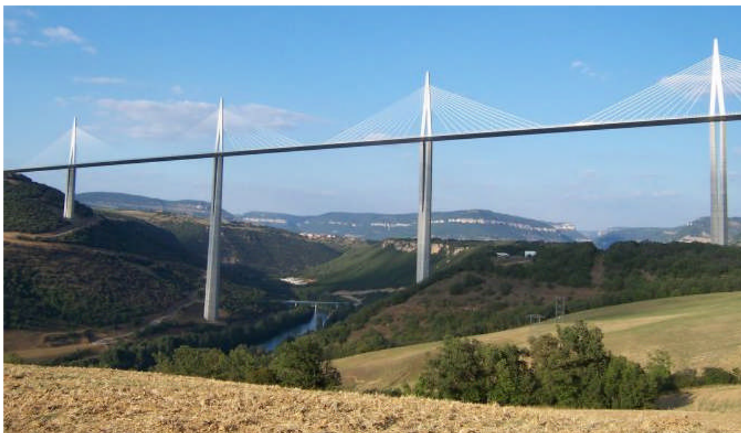
Figura 41: Viaducto de Millau
