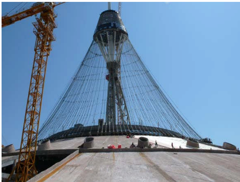
Figura 13: Tensado de cables Centro de Entretenimiento Khan Shatyr FUENTE: http://www.fosterandpartners.com/projects/khan-shatyr-entertainment-centre/
