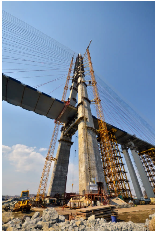
Figura 35: Construcción de torre de Puente Atirantado FUENTE: http://goody-good.rssing.com/chan-2249406/all_p207.html
