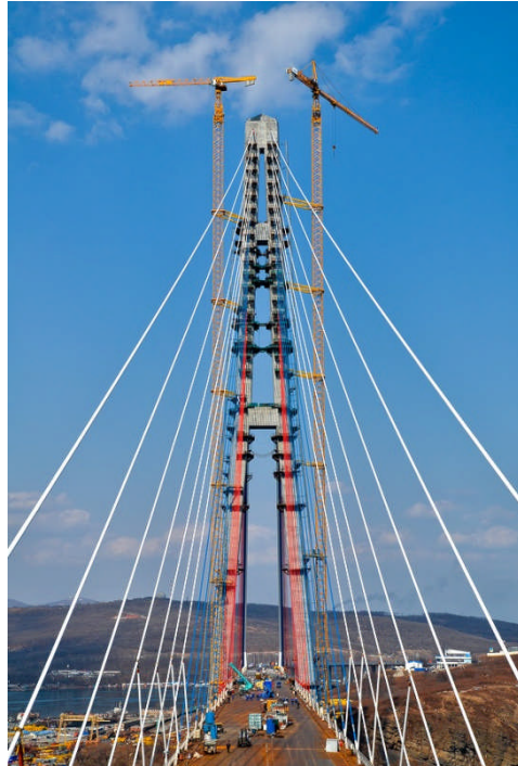
Figura 36: Construcción de torre de Puente Atirantado FUENTE: http://goody-good.rssing.com/chan-2249406/all_p207.html
