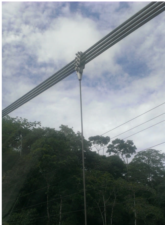
Figura 16: Conexión de cable principal y péndolas
