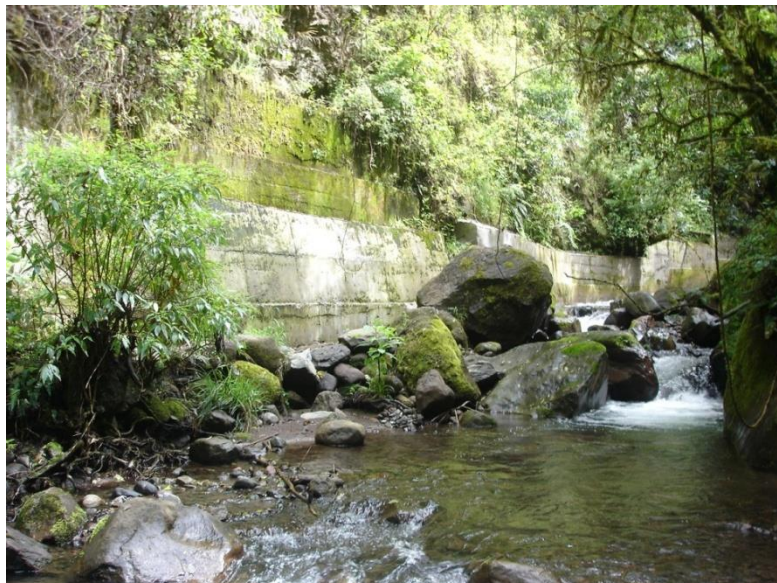
Foto No.8 Bocatoma del canal Tipuya
