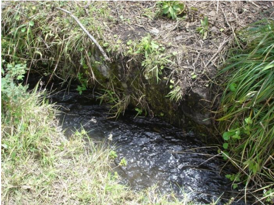
Foto No.12 Tramo en piedra
