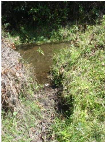
Foto No.9 Canal secundario del canal Tipuya
