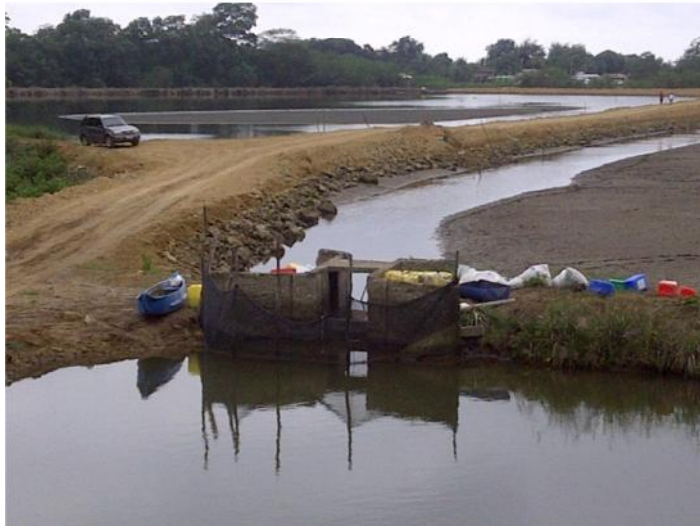
Compuerta de la piscina 1 de la camaronera los Ángeles
