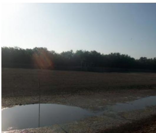
Limpieza de piscina (Foto N°4)
