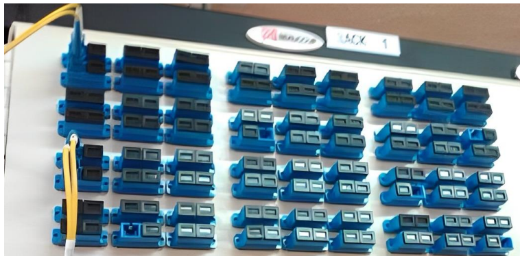
Figura 15 Organizador de Fibra 144 hilos
