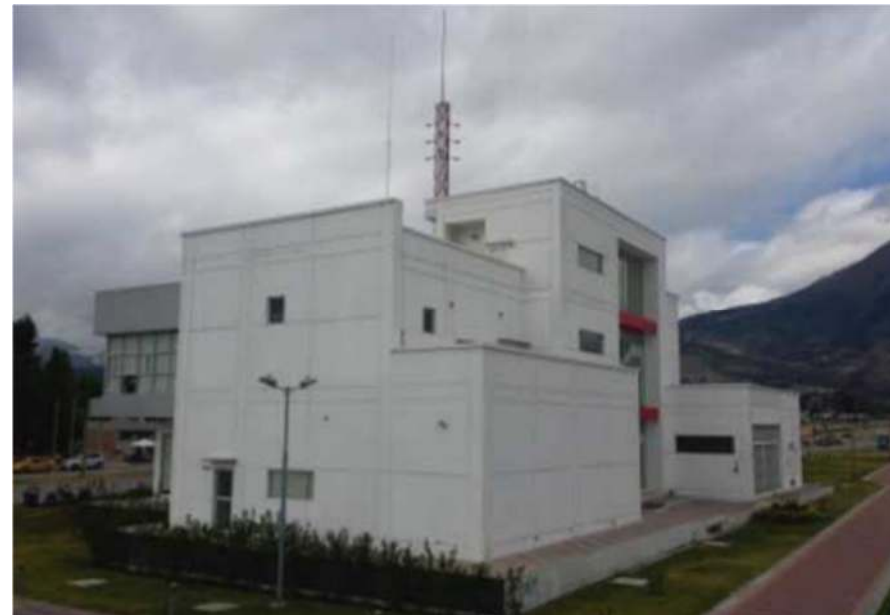
Figura 89: Ecu 9-11. Fuente: Elaboración propia.
