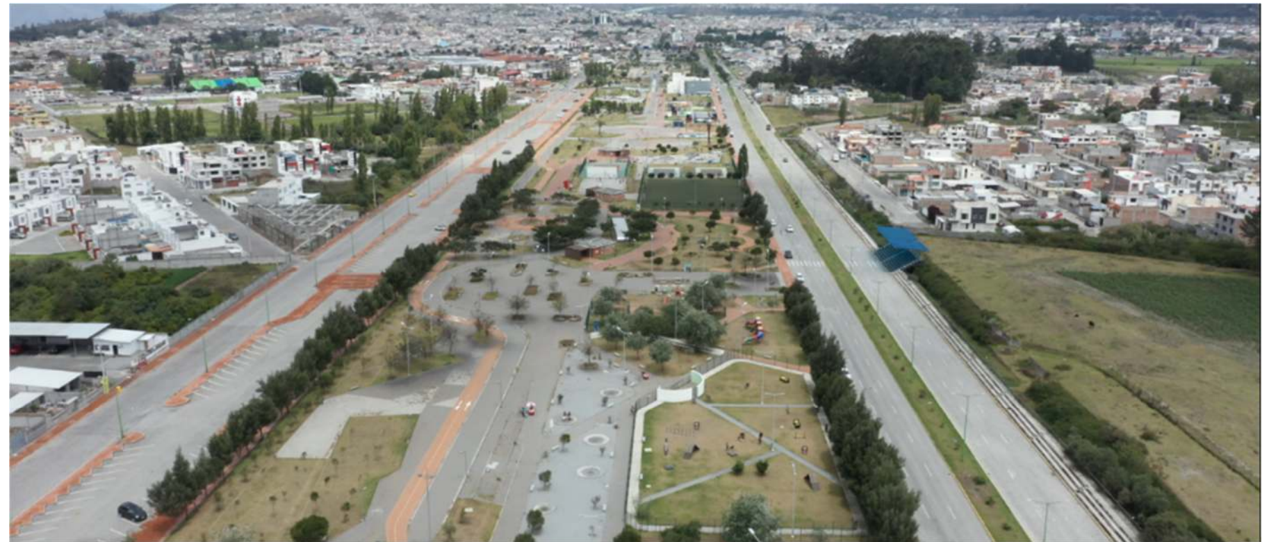
Figura 3: Fotografía aérea del sector centro del parque Ciudad Blanca Fuente: Elaboración Propia
