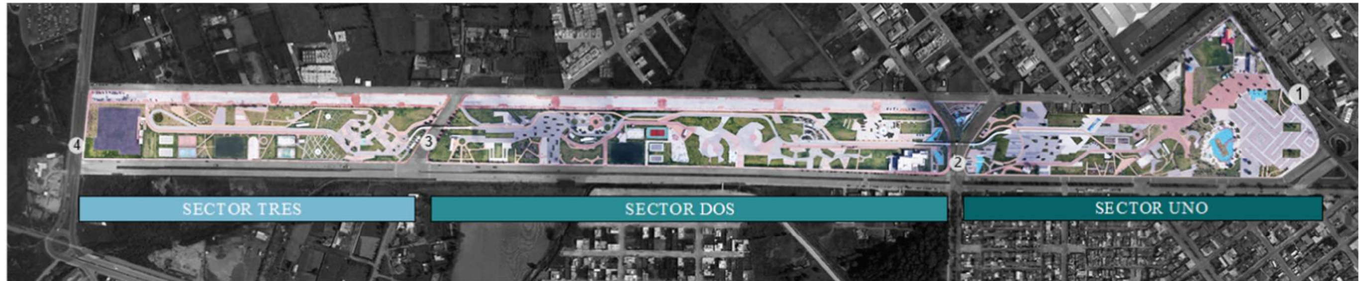
Figura 141: Imagen aérea Parque Ciudad Blanca Elaboración: Propia.
