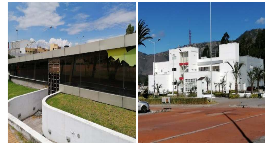
Figura 22: Módulo de internet y ECU 911. Fuente: Elaboración propia.
