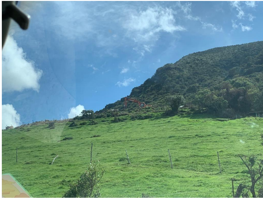
Sitio: Obras civiles- Laguna de San Marcos Fuente: El Autor
