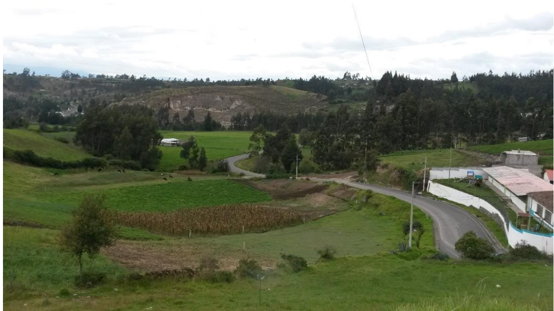
Figura 46. Vía Latacunga- Belisario Quevedo (Sector Culaguango).
