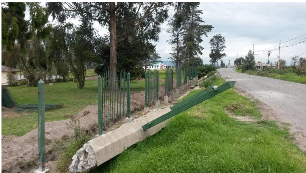
Figura 50. Exterior de la ESPE- Latacunga (Trabajos iniciados para la construcción del nuevo cerramiento debido a la ampliación de la vía a realizarse).
