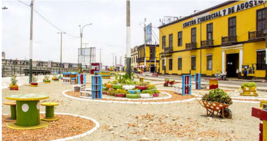
Imagen 6. Plazoleta de la integración luego de la intervención
