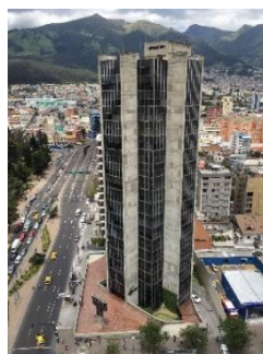
Ilustración 20: Edificio COFIEC Fuente: González D. (2018)
