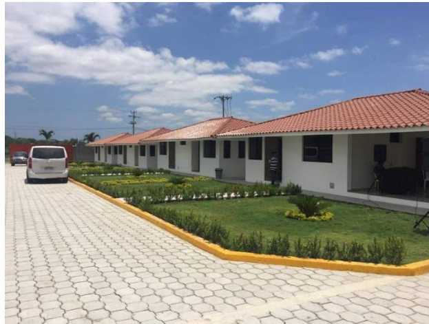
Figura 14. Hospedaje y Garajes Manta
