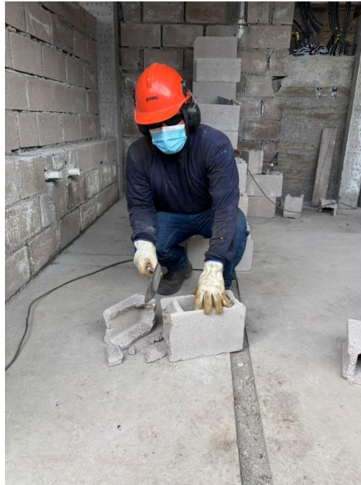
Corte de Bloques con Martillo y Cincel
