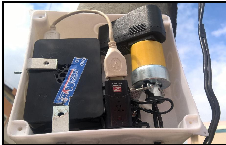
Figura 8: Implementación del segundo punto de captación
