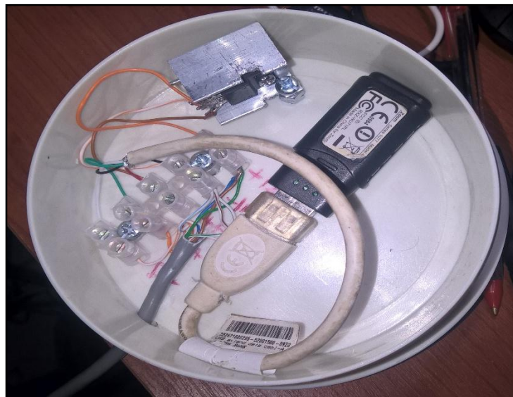
Figura 3: Cajas de seguridad y protección de equipo
