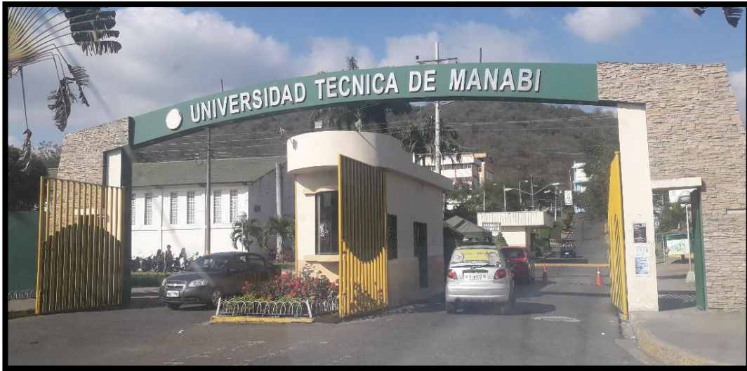
Figura 5: Puerta de acceso vehicular N°2
