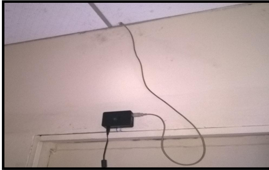
Figura 7: Instalación de la Raspberry Pi
