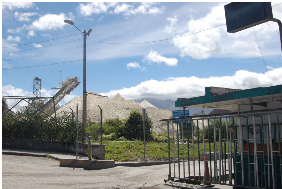
Fotografía 2. Zona de trituración de la piedra caliza para su posterior mezcla y formación de material de cemento (Sol Suárez, Junio 2016).
