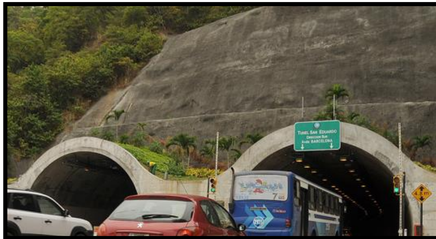
IMAGEN 4.3 – Túnel San Eduardo
