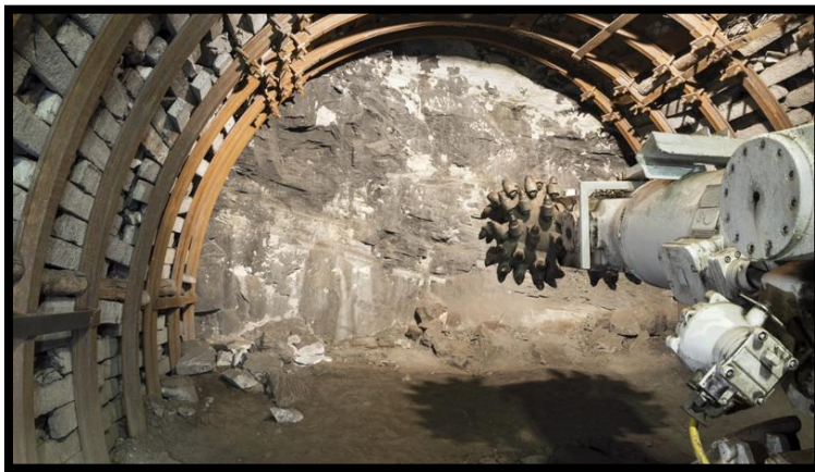
IMAGEN 1.5 - Rozadora en el frente de excavación
