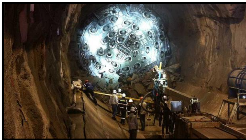
IMAGEN 4.5 – Perforación del túnel de conducción en el Proyecto Coca – Codo Sinclair.
