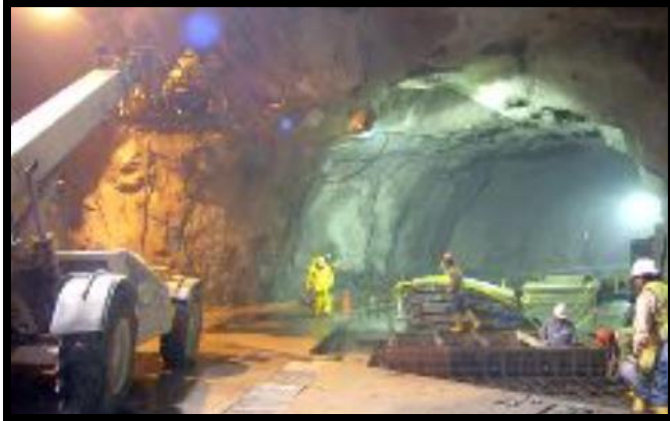
IMAGEN 4.6 – Excavación del Túnel de conducción Agoyán-San Francisco
