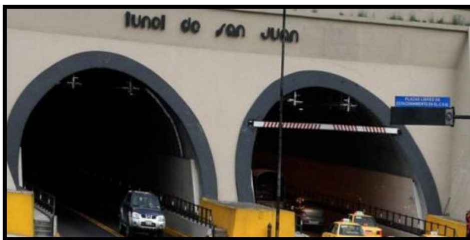
IMAGEN 4.1 – Túnel de San Juan
