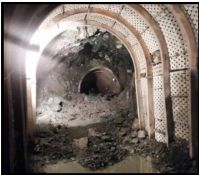
IMAGEN 4.7 – Túnel trasvase San Marcos
