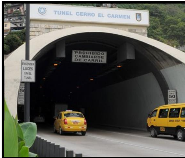
IMAGEN 4.4 – Túnel Cerro El Carmen
