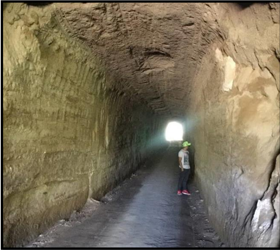
IMAGEN 4.20- Interior túnel de la vía Tolontag – Píntag
