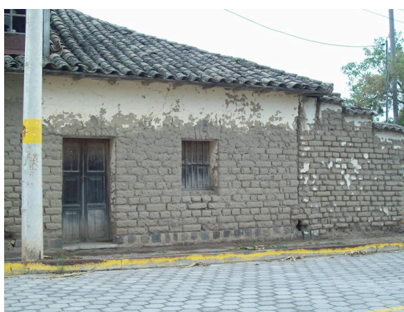
Fotografía 12: Fachada vivienda típica
