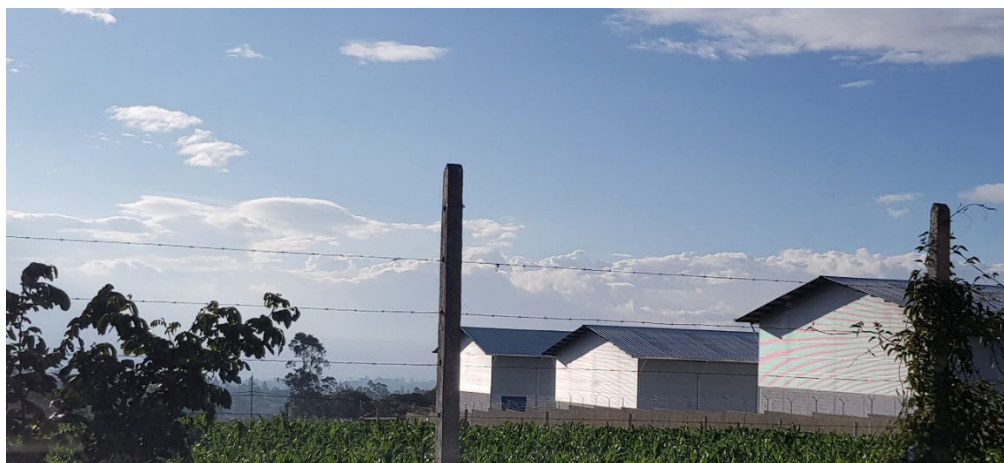
Fotografía 4: Vista hacia la construcción de bodegas
