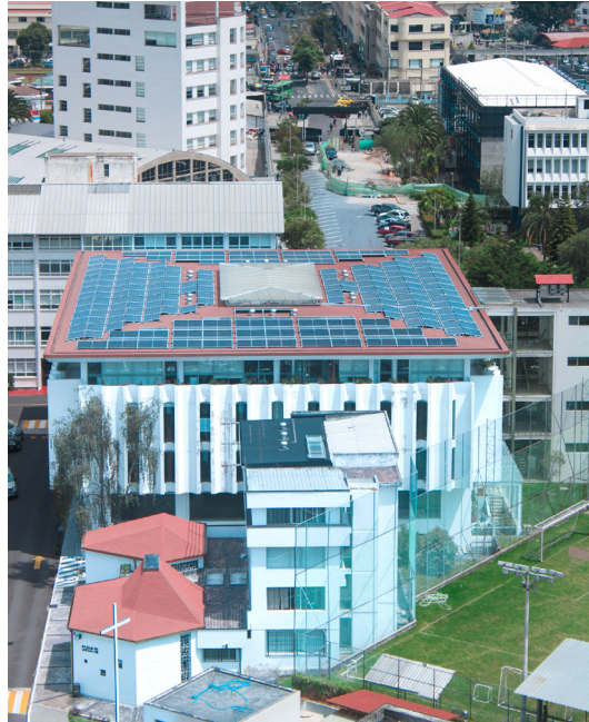
Figura 1 Paneles solares biblioteca
