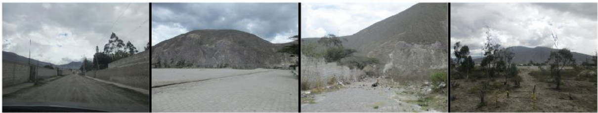
Figura 40: Estado Vías Existentes.
