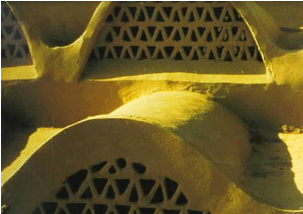
Figura 17 Construcción en tierra, Hassan Fathy. (CQ, 2011)
