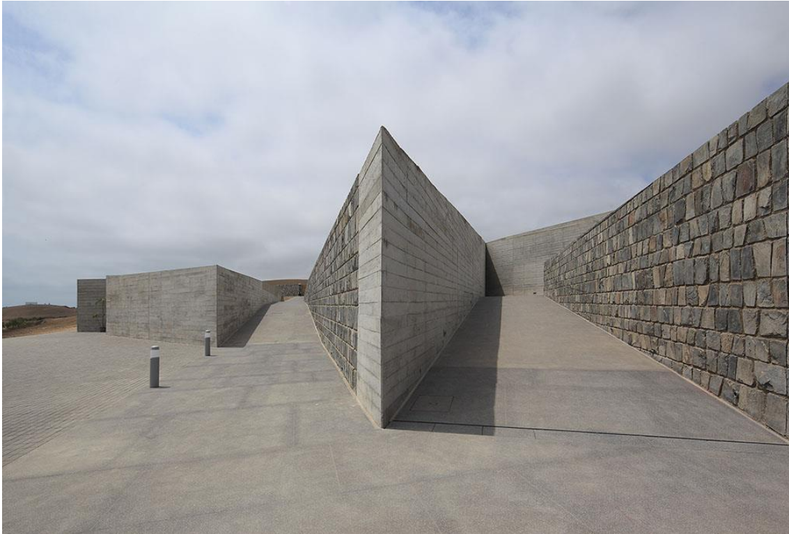
Figura 21 Museo de Sitio Pachacamac. Circulación y muros. ( Arquitectura de la Ciudad, 2012 )
