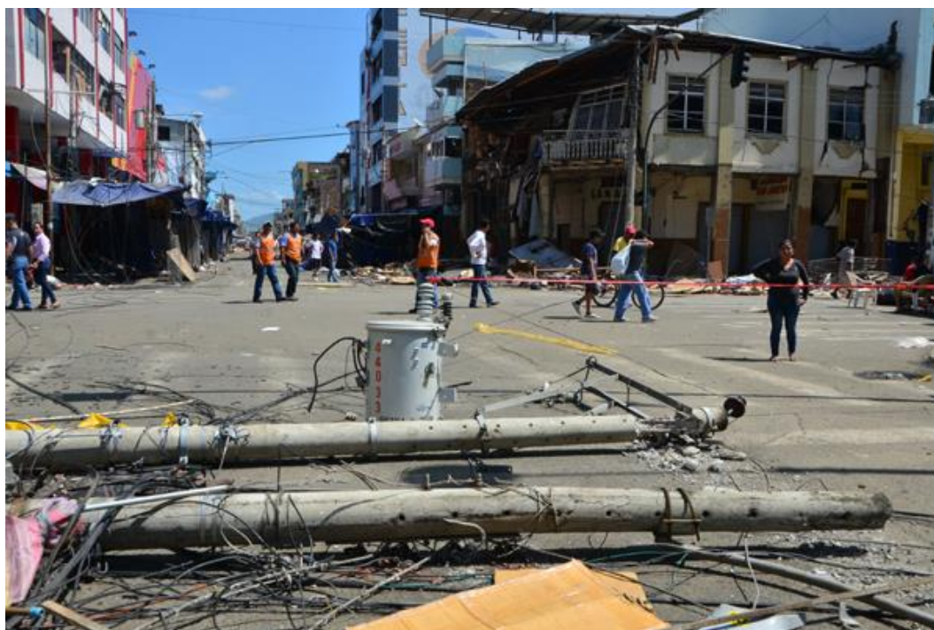
Ilustración 2: Daños en red eléctrica
