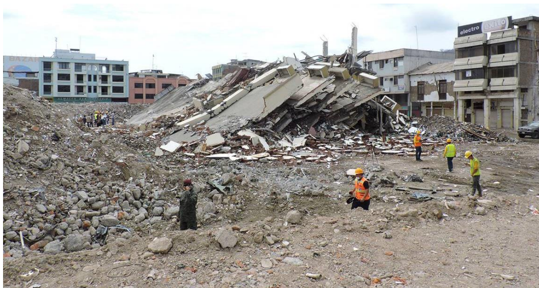
Ilustración 6: Demolición de Centro Comercial Municipal. Destrucción del casco comercial de Portoviejo
