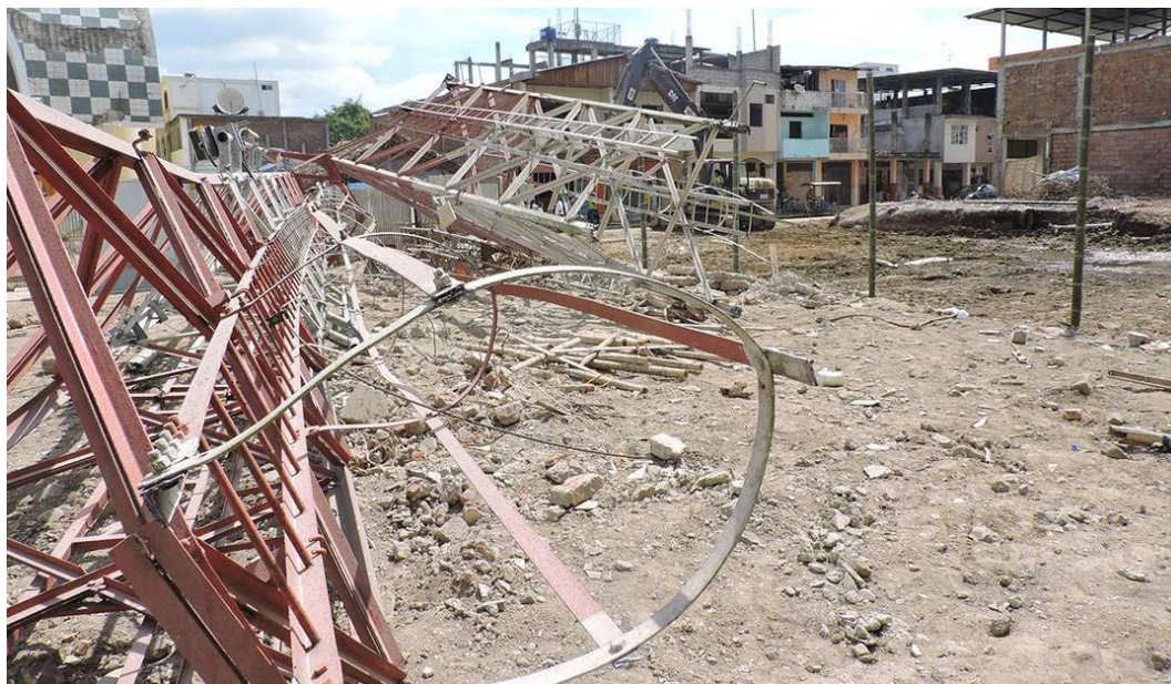
Ilustración 3: Antenas de telecomunicaciones destruidas
