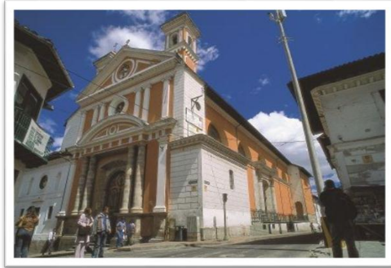
Ilustración 1. Edificio de Santa Catalina de Siena Barrio San Marcos
