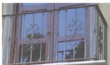
Imagen: 27 Barandal de hierro forjado
