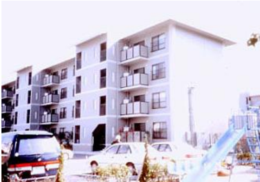
Foto 7.11: Desempeño satisfactorio de un edificio de apartamentos de concreto prefabricado, preesforzado en el terremoto de Kobe en 1995.
