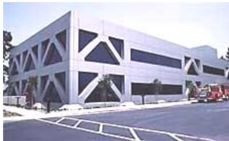
Foto 4.6: Departamento de Comando de Incendios y Facilidad de Control.
