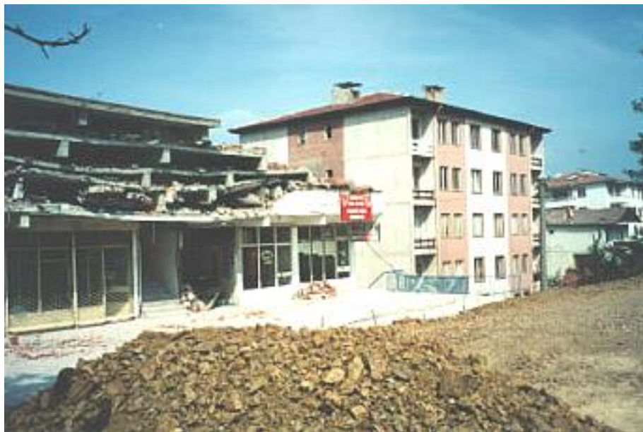
Fotos 7.13: Desempeño satisfactorio de los edificios de apartamentos de concreto prefabricado, preesforzado en el terremoto de Kocaeli, Turquía 1999.
