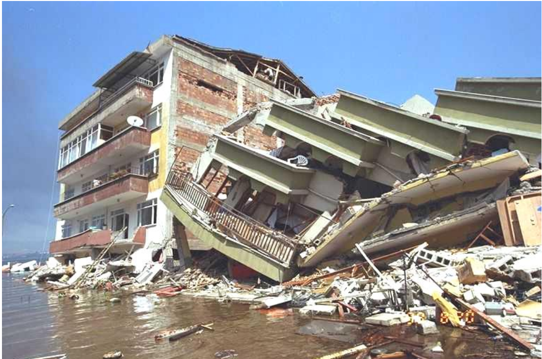
Foto 6.7a: El terremoto Izmit (Kocaeli), terremoto de Turquía, agosto 17 de 1999, Magnitud 7.4. En el litoral se hundió, produciéndose una inundación y daño estructural y fracasos en la construcción.
