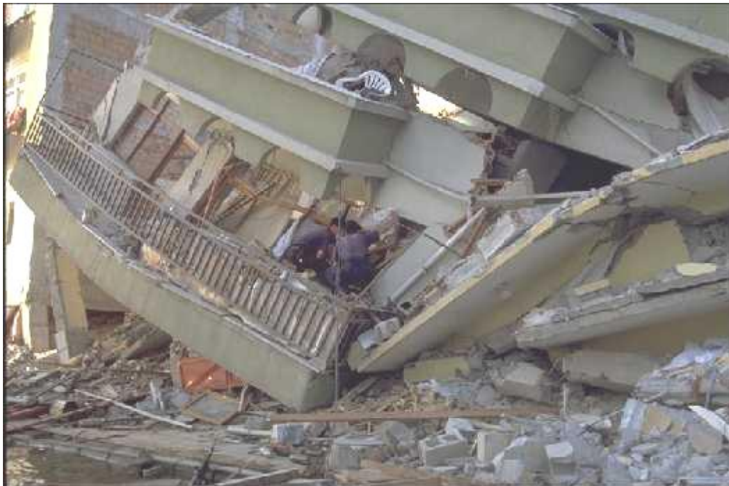
Foto 6.7b: Colapso total de un edificio.
