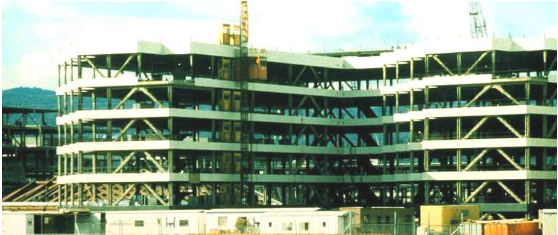
Foto 4.3: Estructura con marcos asegurados.
