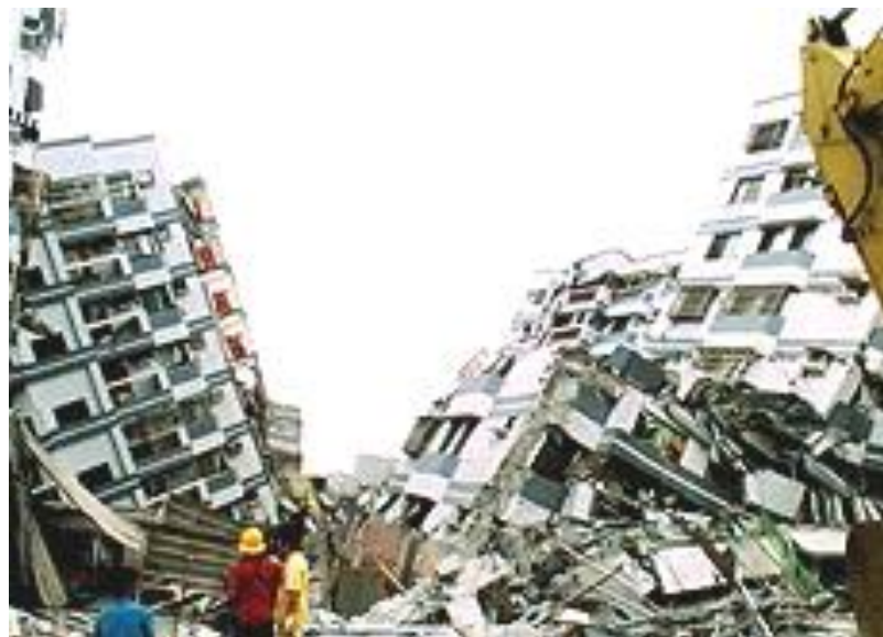
Foto 6.11: Edificio que se partió en dos.
