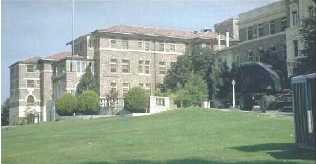
Foto 3.7: Hospital General Kern. Marco de acero, pisos de concreto, paredes exteriores no reforzadas de ladrillo: una pérdida total. El fondo del edificio en el extremo izquierdo fue diseñado para resistir impacto y no sufrió daño. Esta foto fue tomada 8 días después del terremoto del 21 de Julio de 1952 en el Condado de Kern, de magnitud 7.69.
