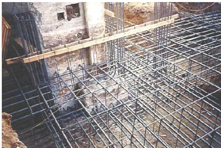
Foto 6.38: Factores constructivos (reforzamiento estructural).
