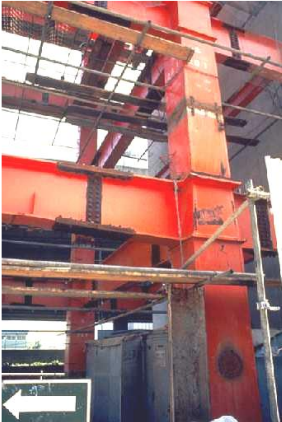
Foto 7.10: Edificio de estructura metálica reforzada, en donde se producirían las rótulas plásticas.
