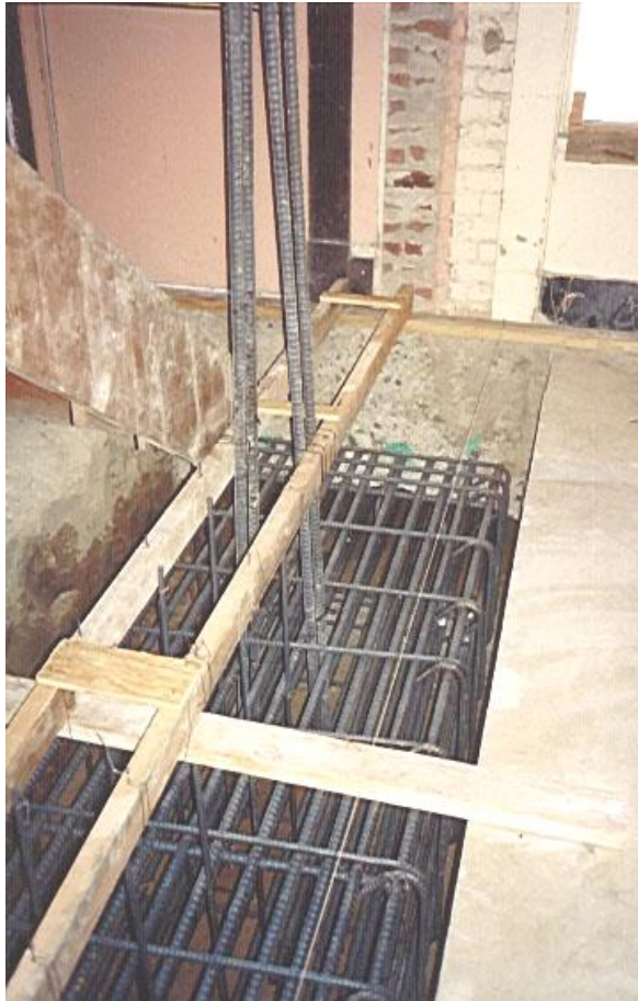
Foto 6.39: Edificio que se está reforzando.
