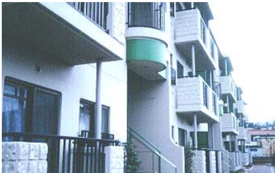
Foto 7.12: Desempeño satisfactorio de otro edificio de apartamentos de concreto prefabricado, preesforzado en el terremoto de Kobe en 1995.
