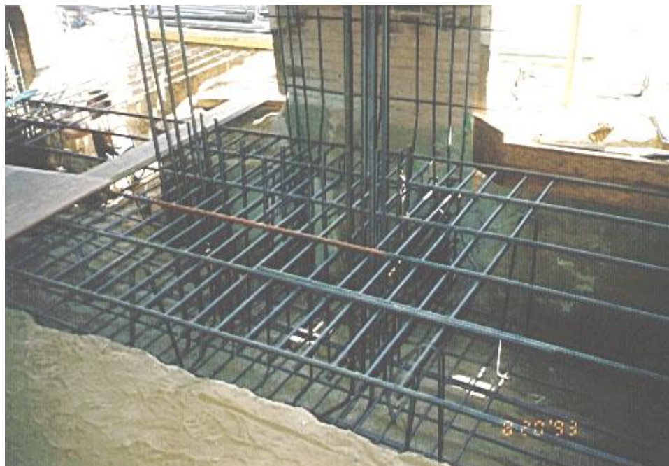
Foto 6.40: Edificio que se está reforzando.
