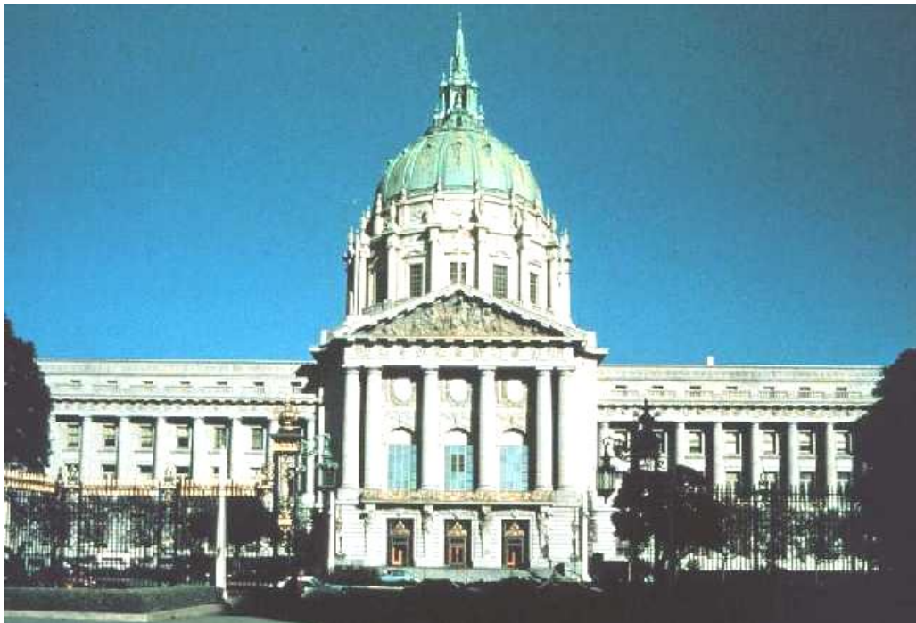
Foto 4.11: Edificio rehabilitado con aislamiento de base.
