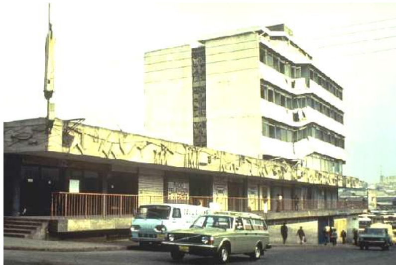
Foto 6.20: Edificio con irregularidad en planta.
