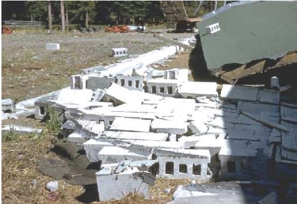
Foto 7.26: Colapso de un edificio de mampostería de bloque sin confinar.
