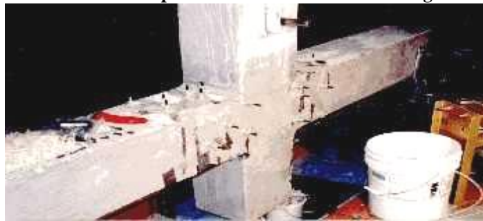
Foto 6.44: Reparación de estructuras de hormigón.
