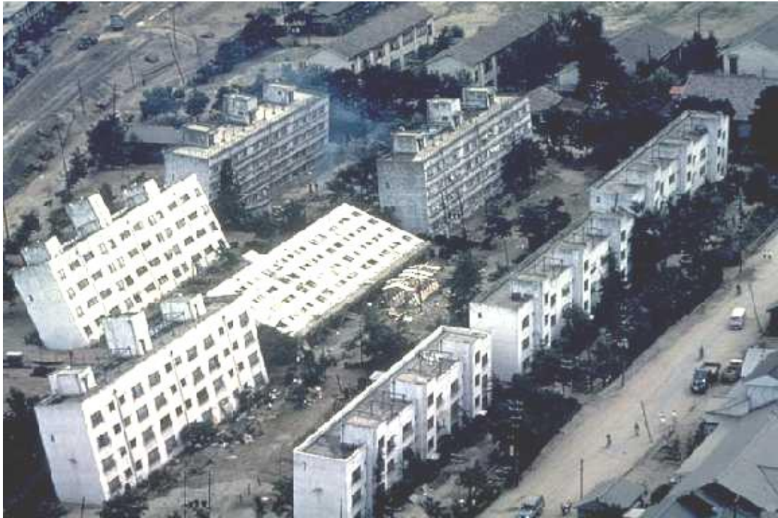
Foto 1.3: Daños en estructuras por licuefacción.
