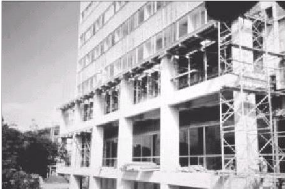
Foto 7.4: La construcción de un sistema de pórtico nuevo. Uso de marcos perimétricos externos para reforzar el Hospital de México en un proyecto llevado a cabo por la Fundación de Seguridad Social de Costa Rica. Generalmente esto se combina con la incorporación de paredes estructurales internas perpendiculares a la dirección longitudinal de los marcos.
