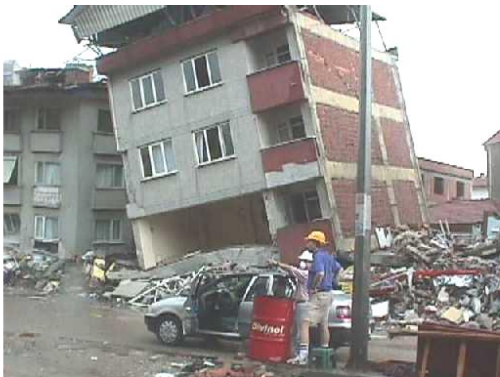
Foto 3.6: Edificio parcialmente destruido debe ser demolido.
