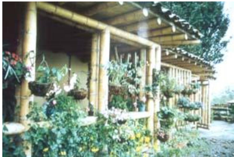
Foto 7.15: Casa construida con caña guadúa que resistió el sismo en Colombia.
