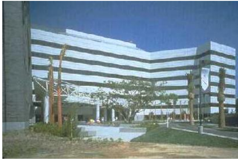
Foto 3.13: Hospital en la universidad del sur de California. Terremoto de Northridge, California, enero 17, 1994, magnitud 6.69.
