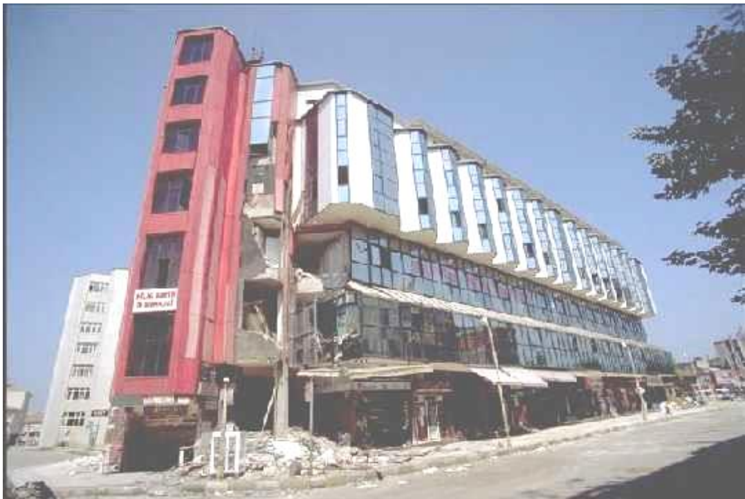
Foto 6.19: Excentricidad excesiva.
