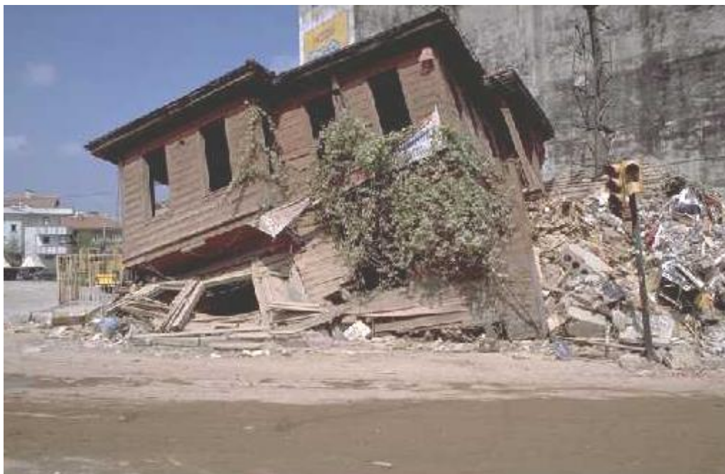
Foto 7.23: Vivienda de madera destruida por un terremoto.
