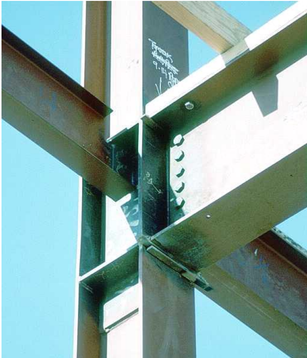
Foto 4.2: Unión vigas-columna en estructura metálica.
