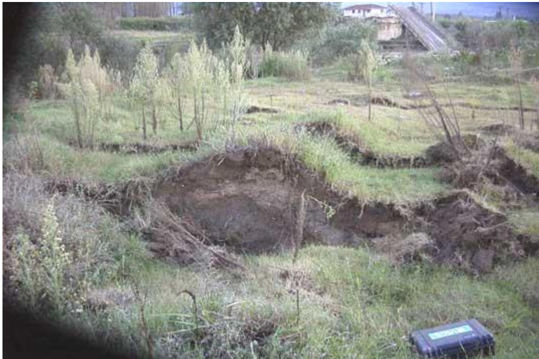
Foto 1.4: Daños en terrenos por licuefacción.
