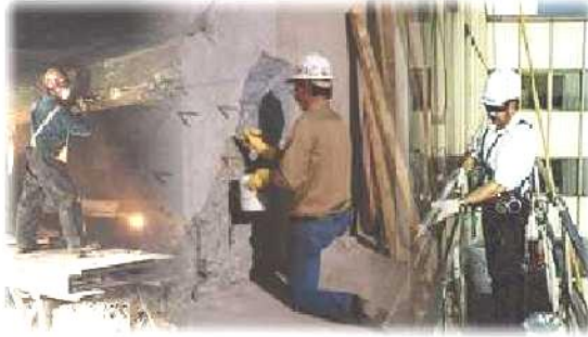
Foto 6.43: Reparación de estructuras de hormigón.
