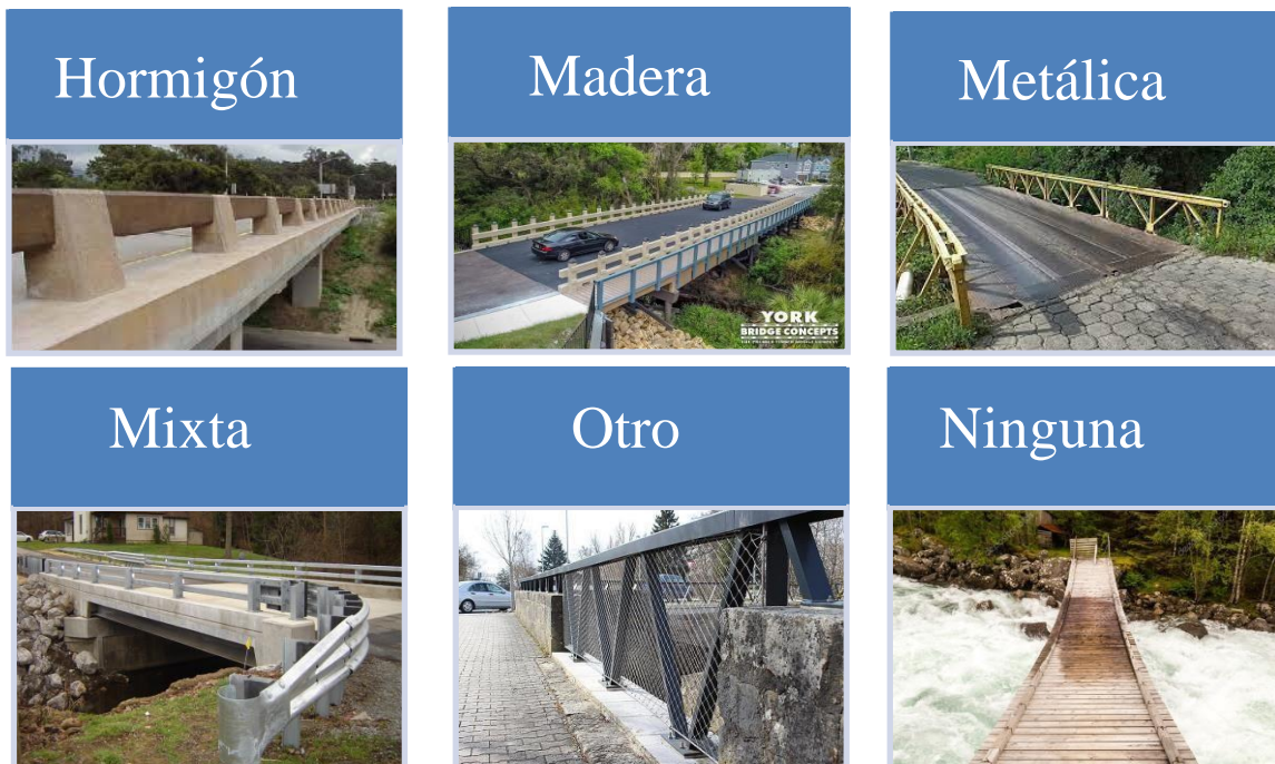
Ilustración 9 Tipo de material de puentes
