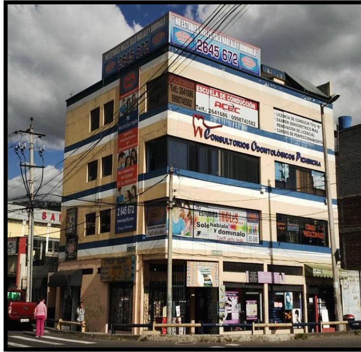
Figura 7. Parte externa del edificio Enquality. Tomado de edificio Cerro Hermoso- Enquality Villaflora, 2018
