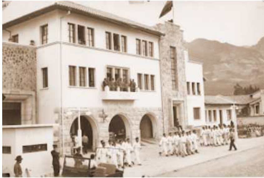
Figura 24. Estación de Bomberos #1, Edwin Adler Teller, 1960 (Fuente: Archivo del Cuerpo de Bomberos de Quito)
