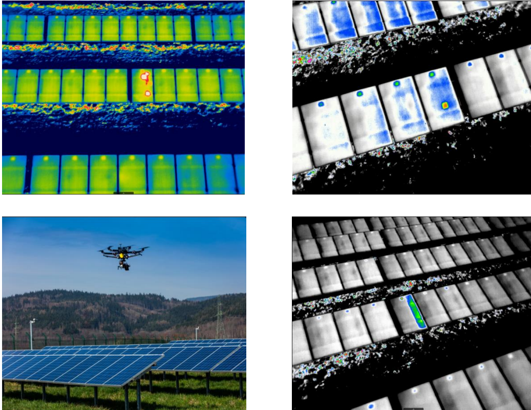
Figura 18. Imágenes térmicas de paneles solares
