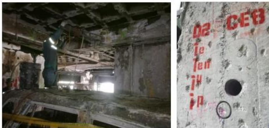
Ilustración 25: Extracción de núcleos
