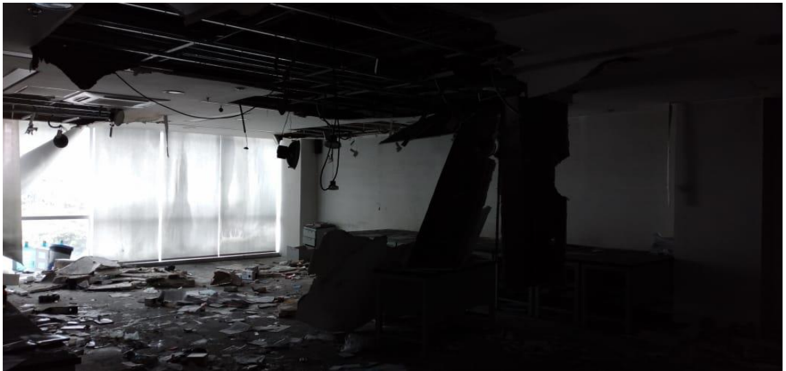
Ilustración 19: Piso 4 vidrios de oficina que cedieron ante el calor Fuente: CEE
