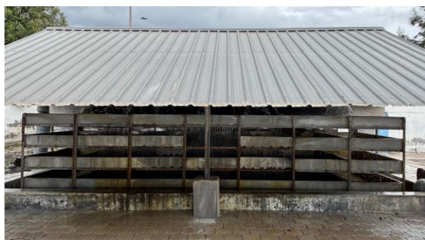
Figura 5. Infraestructura de la torre de aireación.
