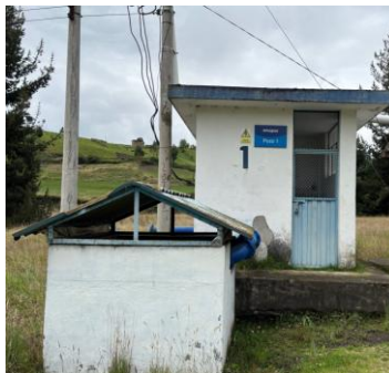
Figura 2. Caseta de bombeo en pozo profundo.
