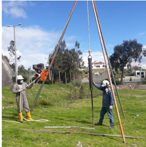
Imagen 6: Ensayo SPT in situ. Fuente: (TAMDRILLING, 2024)
