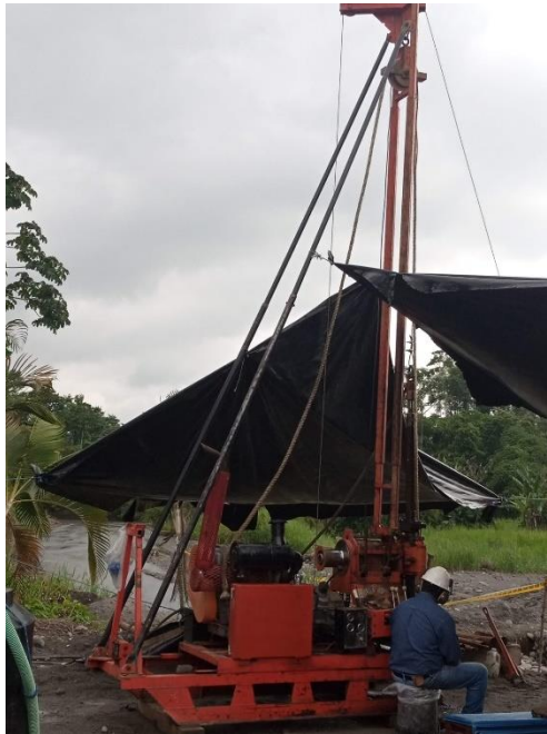
Imagen 14: Maquina de perforación con castillo ubicado. Fuente: (TAMDRILLING, 2024)
