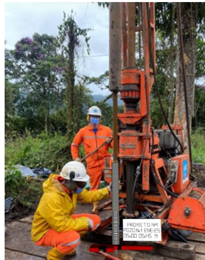
Figura 38: Ejecución del ensayo de SPT. Fuente: (AOC INGENIERIA , 2021)
