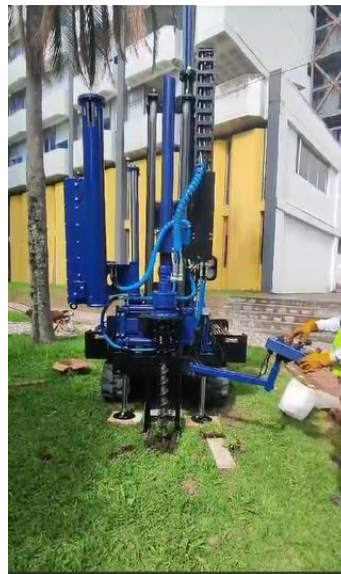
Imagen 34: Limpieza del pozo.
