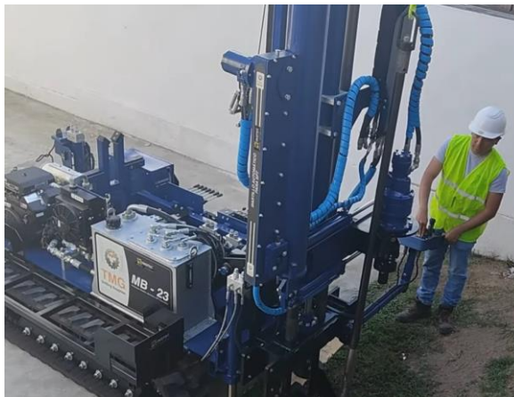
Imagen 31: Ingreso de tubería con muestreador de tubo partido. Fuente: (Ingeniería Técnica Rcingtec, s.f.)
