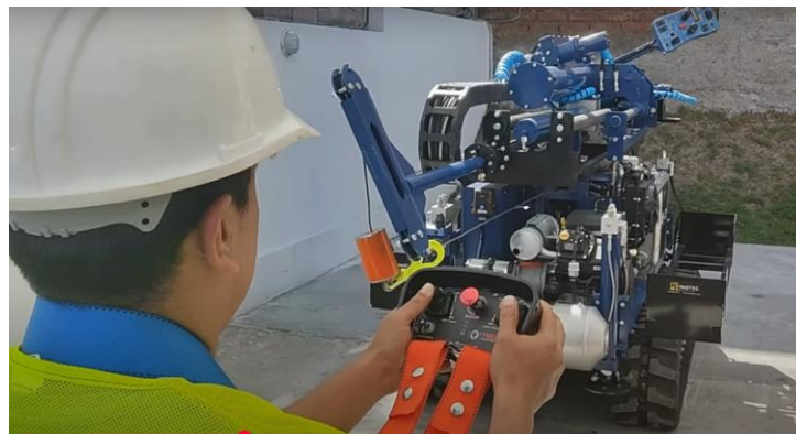
Imagen 25: Desplazamiento de máquina automática de SPT MB-23 TMG DRILLING Fuente: (Ingeniería Técnica Rcingtec, s.f.)
