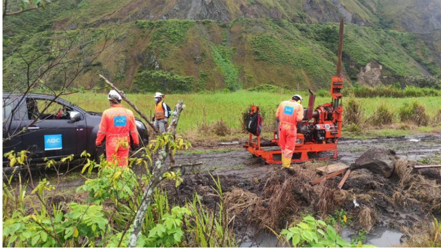
Imagen 11: Máquina semi automática enganchada a camioneta. Fuente: (AOC INGENIERIA , 2021)
