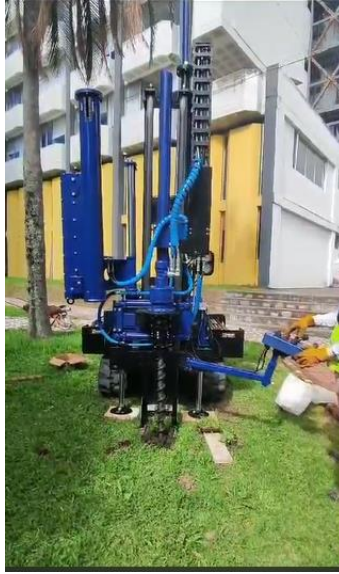
Imagen 30: Ingreso del barreno a nivel de cota del ensayo. Fuente: (Ingeniería Técnica Rcingtec, s.f.)
