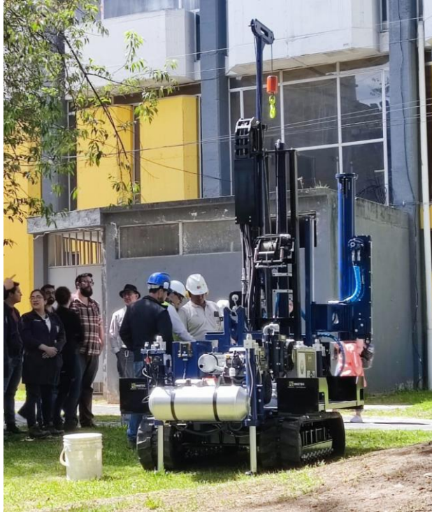
Imagen 4: Capacitación de operación máquina automática SPT. Fuente: (Ingeniería Técnica Rcingtec, s.f.)
