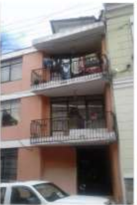
IMAGEN 10. Fachada vivienda en San Marcos.
