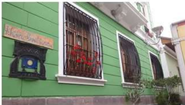
Fachada local censado en San Marcos
