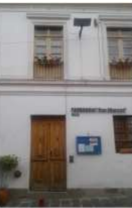
IMAGEN 11. Fachada establecimiento censado en San Marcos.
