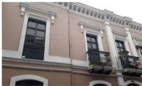
Fachada de una casa de la calle Junín
