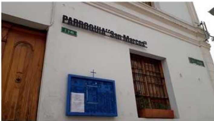
Fachada casa parroquial San Marcos
