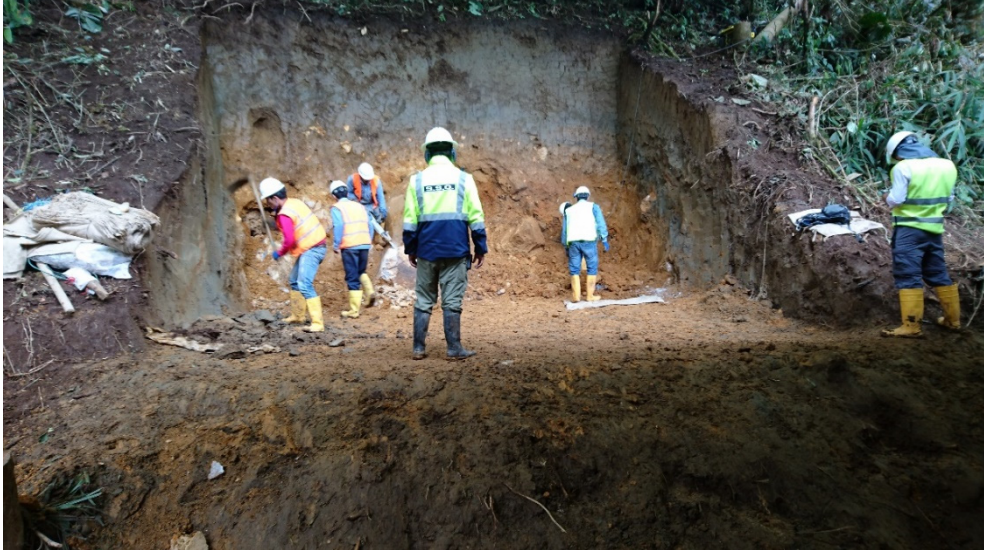
Figura 5: Construcción de Plataforma.
