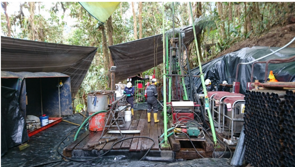
Figura 6: Plataforma de perforación
