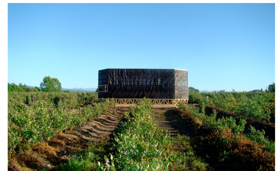
Figura 21: Centro de Acopio Quintasur.
