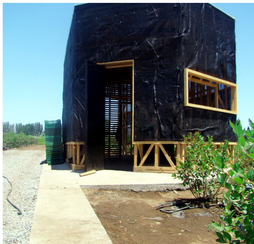
Figura 28: Vista Exterior, Centro de Acopio Quintasur. Fuente: Nelson Parra Carrasco, Plataforma Arquitectura.
