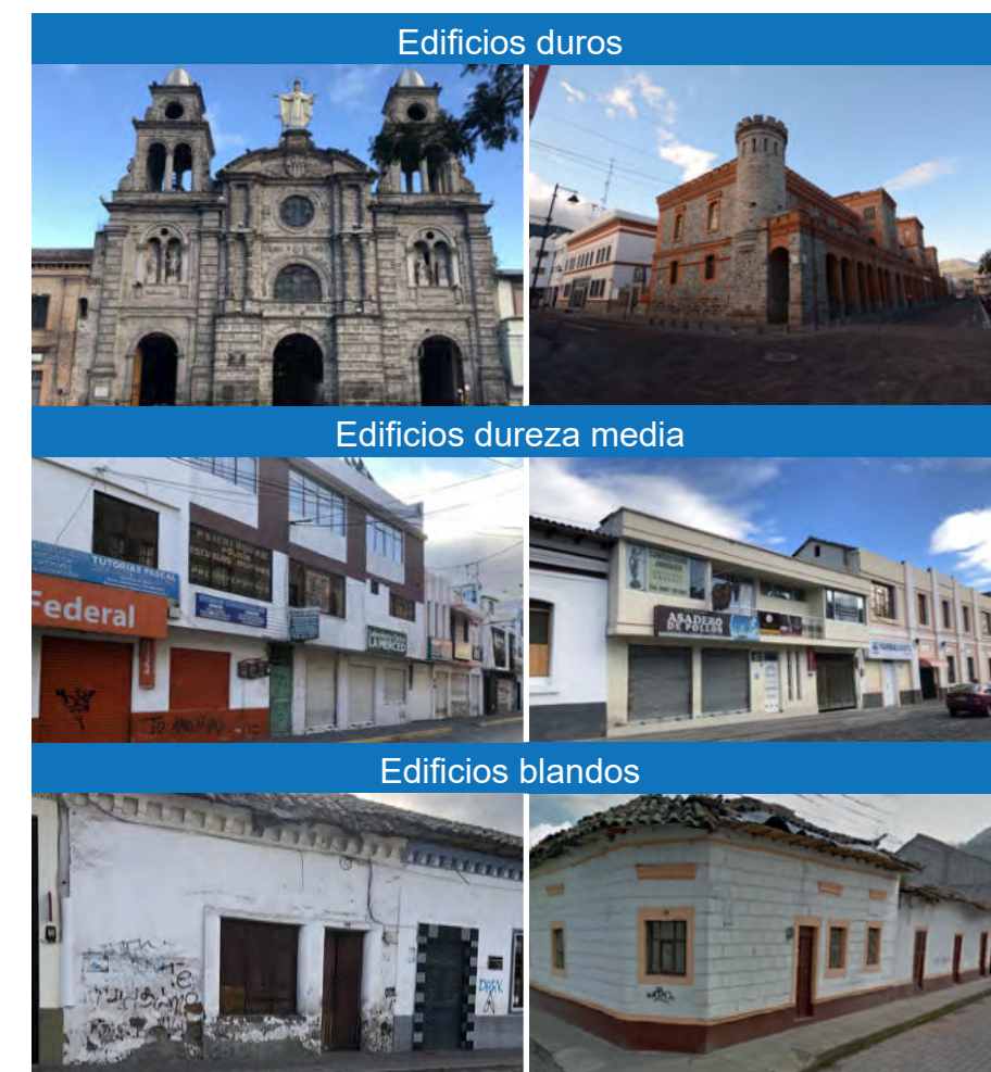
Figura 109. Fotografías de edificaciones del sector.
