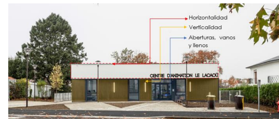
Figura 27. Elementos componentes sobre fotografía fachada frontal Fuente: Adrià Goula, (2015). Modificado por: Autora, (2020).
