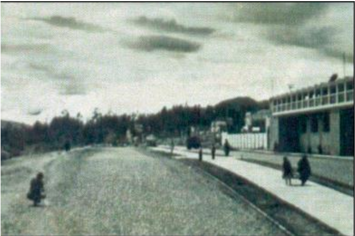
Figura 49. Av. Bolivariana a la derecha la fachada de la tribuna 1960. Fuente: (CISEPP, 2013)
