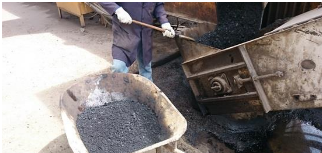
Fotografía 1-2 Obtención de la mezcla.
