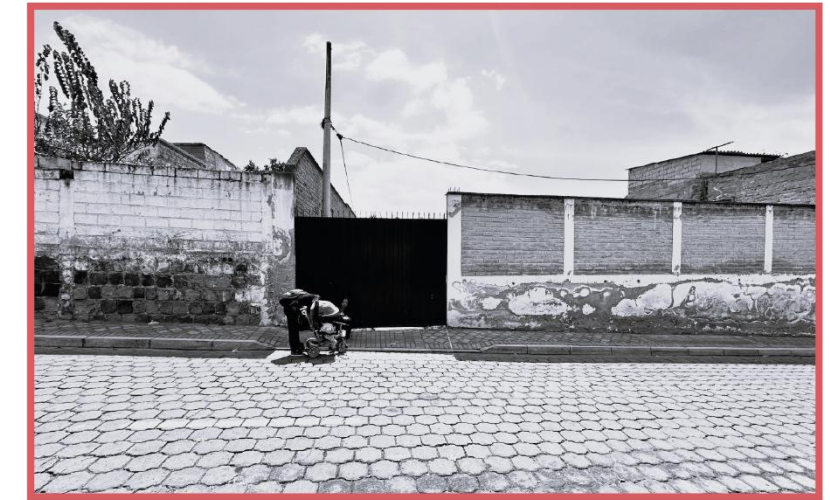
ESTADO ACTUAL DE LA CALLE ANTONIO JOSÉ DE SUCRE
