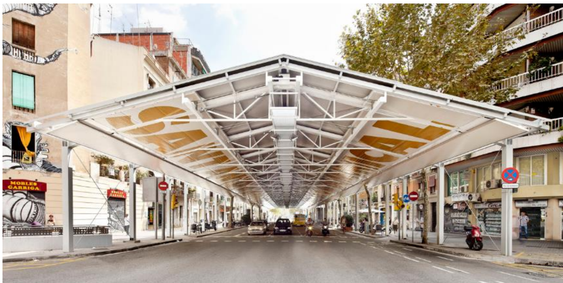
Fotografía 7: Mercado Provisional del Dominical de Sant Antoni (Lunes a sábado) Autor: Ravetllat Ribas Arquitectos
