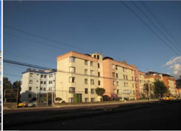
Edificios en Solanda
