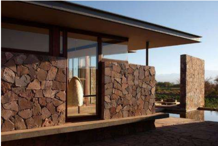
Figura 26: Estructura mixta metálica y piedra
