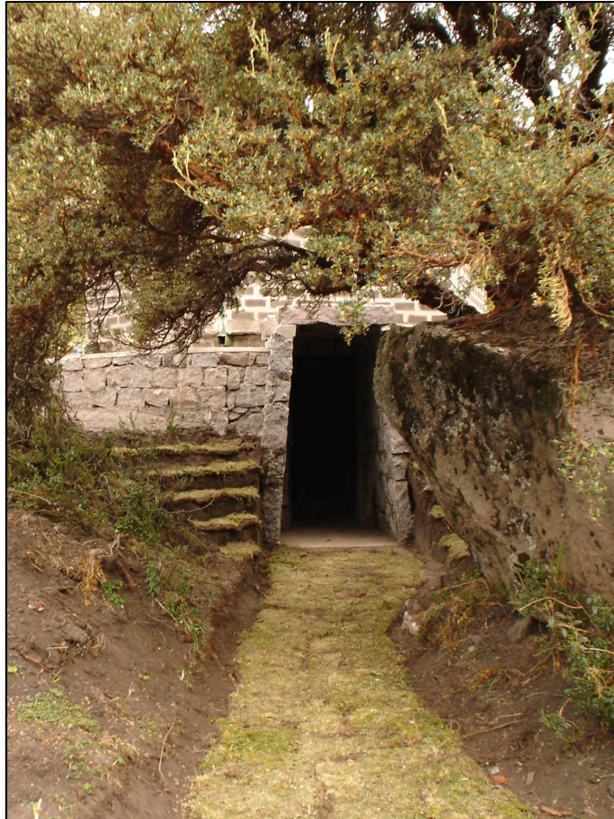
Fotografía 10: Detalle del refugio, puerta de acceso al subsuelo. Fuente: agi 2009.
