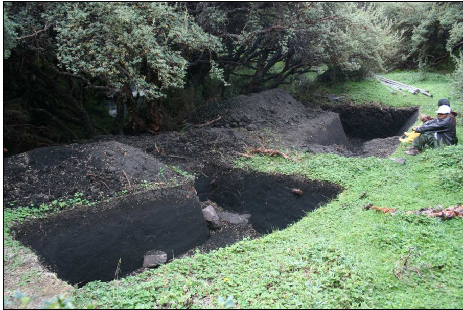
Fotografía 19: Excavación para la construcción de piscinas reproductoras de truchas. Fuente: Bernardo Gortaire, 2010.
