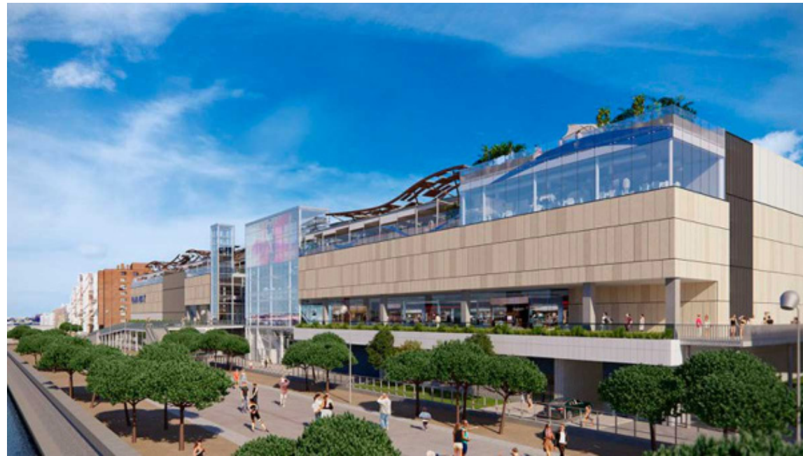
Figura 30 : Centro comercial plaza rio2 Fuente: okdiario.com
