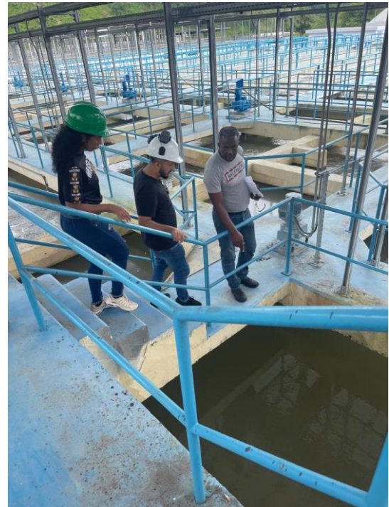
Identificación de riesgo químicos en procesos de producción de agua.
