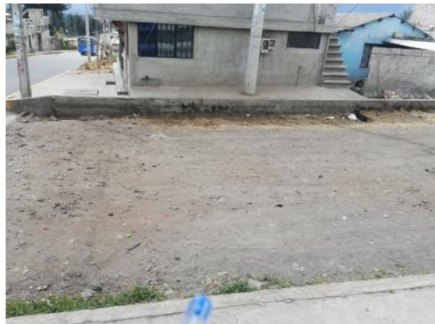
Fotografía 20 Calles sin adoquinar o asfaltar
