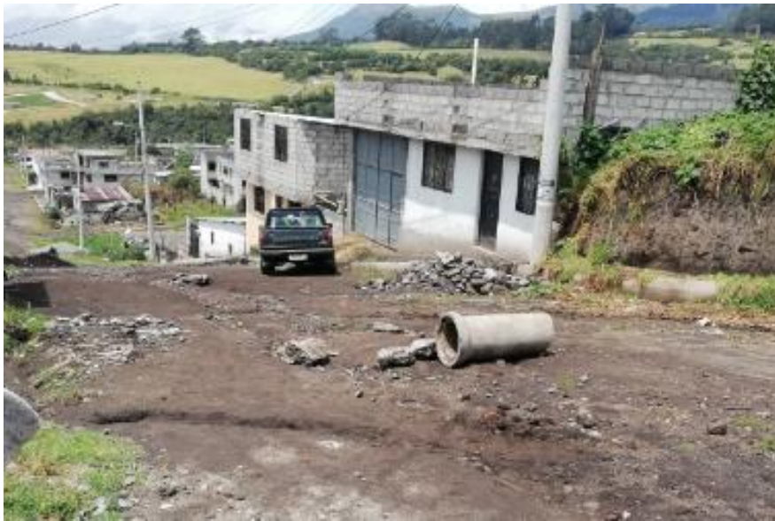
Fotografía 4 Restos de tuberías del alcantarillado
