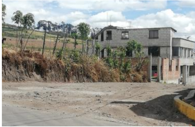
Fotografía 19 Calles sin adoquinar o asfaltar
