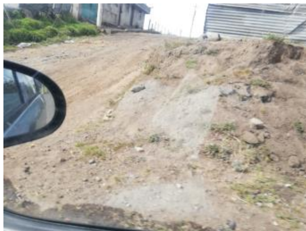
Fotografía 21 Calles sin adoquinar o asfaltar
