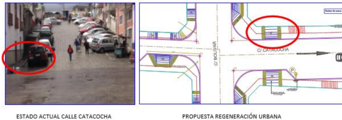
Figura 30. Ejemplo de cruce sin rampa en la calle Catacocha y Bolívar A Fuente: GAD Municipal de Loja.
