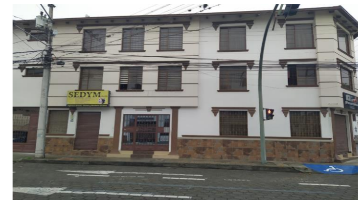
Figura 66. Edificio de uso mixto Fuente: Elaboración propia
