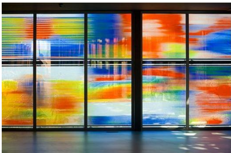
Fotografía 14: Paneles de cristal de la fachada
