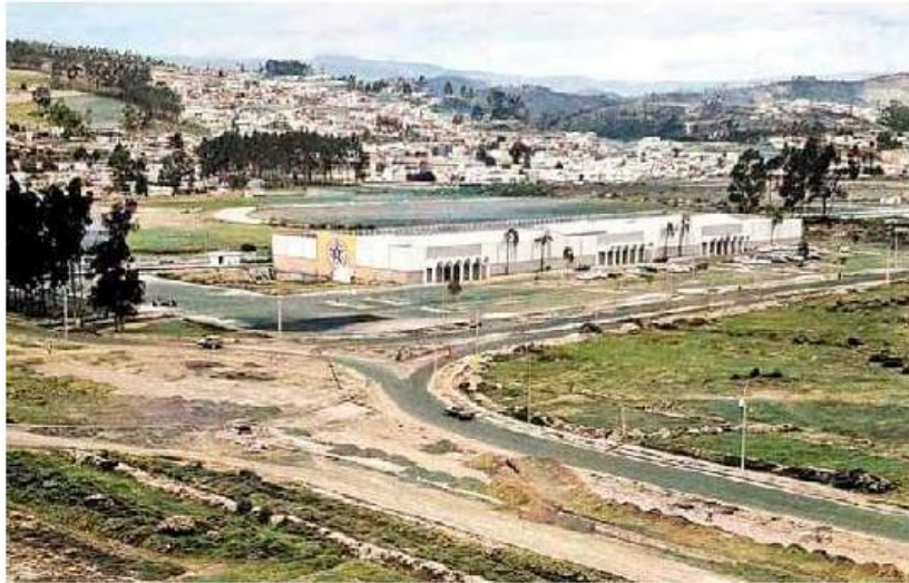
Figura 18. Redondel entre av. Naciones Unidas y av. Amazonas (recuperado de Quito Nostálgico)
