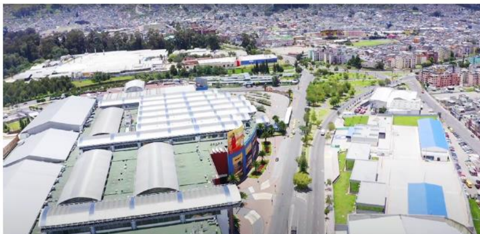
Figura 23. Vista aérea redondel Morán Valverde. (Recuperado de El Comercio)
